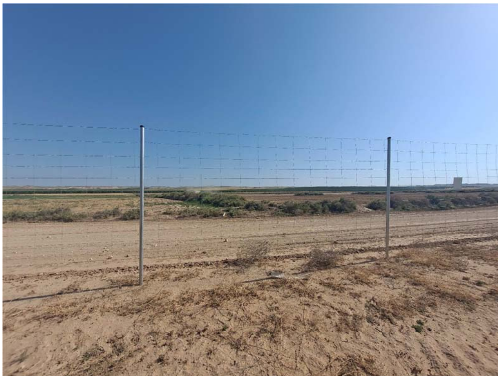
Figura 8.5. Único vano observado sin placa de visibilidad
