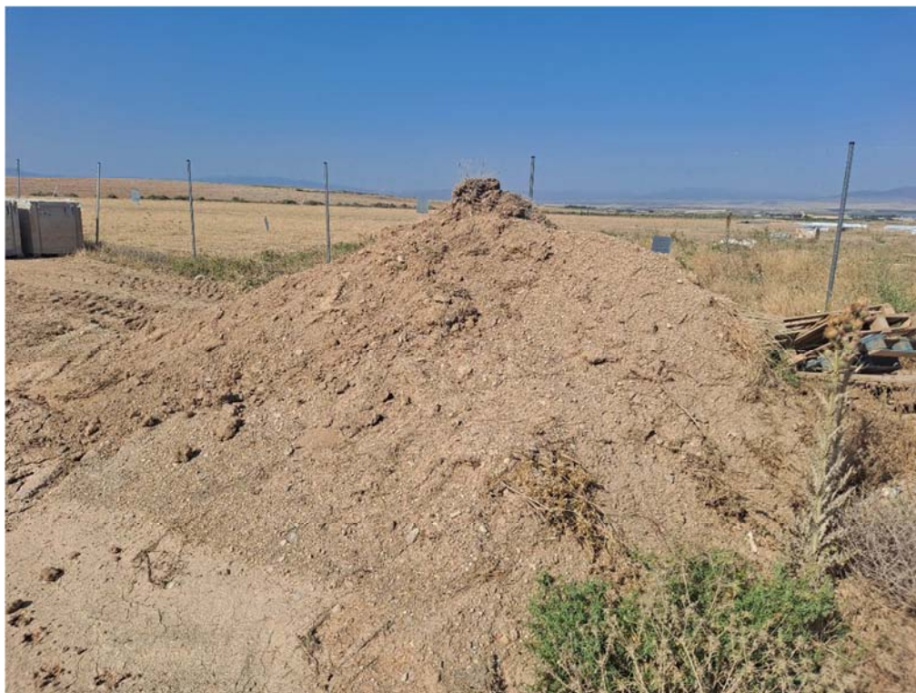
Figura 8.3. Tierra vegetal acopiada, procedente de la zona donde se han acopiado materiales, entre las plantas "San Pedro" y "Épila"
