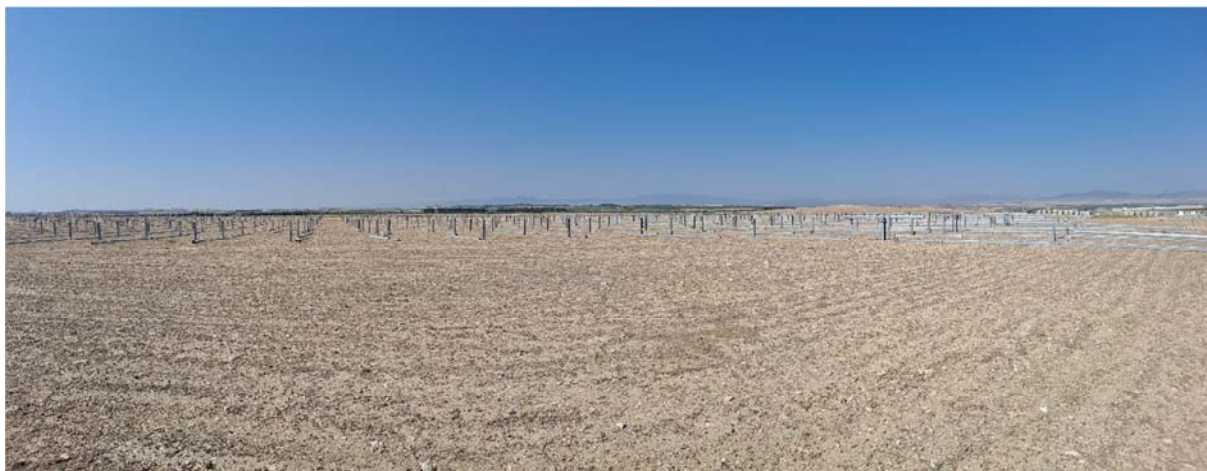
Figura 8.1. Aspecto de la planta a fecha 18-07-24
