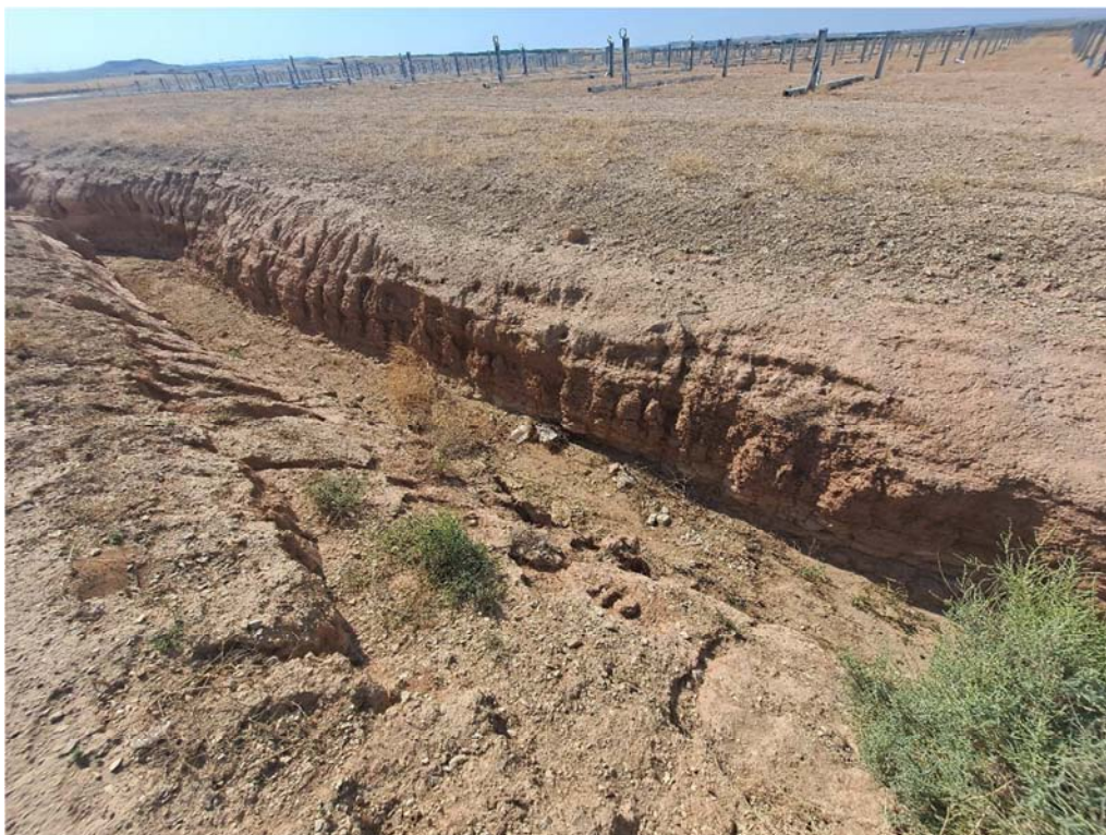
Figura 8.6. Aspecto del barranco que atraviesa la planta, donde se observan signos erosivos y puntualmente algún plástico
