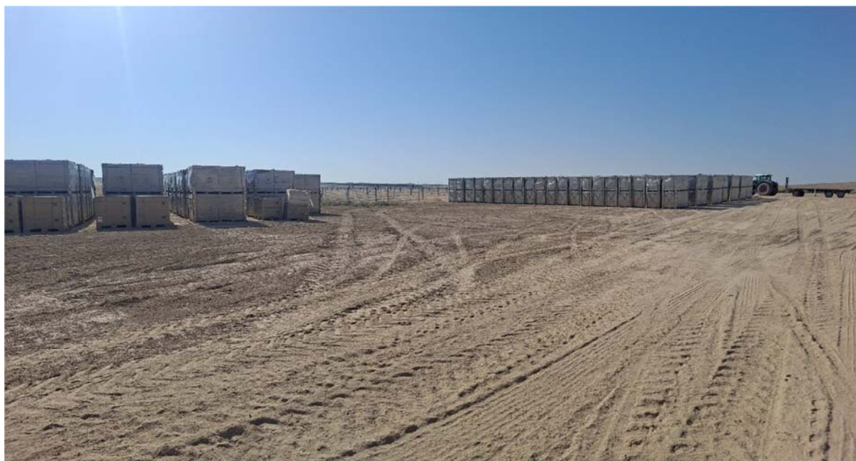
Figura 8.2. Acopios de materiales en los terrenos entre las plantas "Épila" y "San Pedro"
