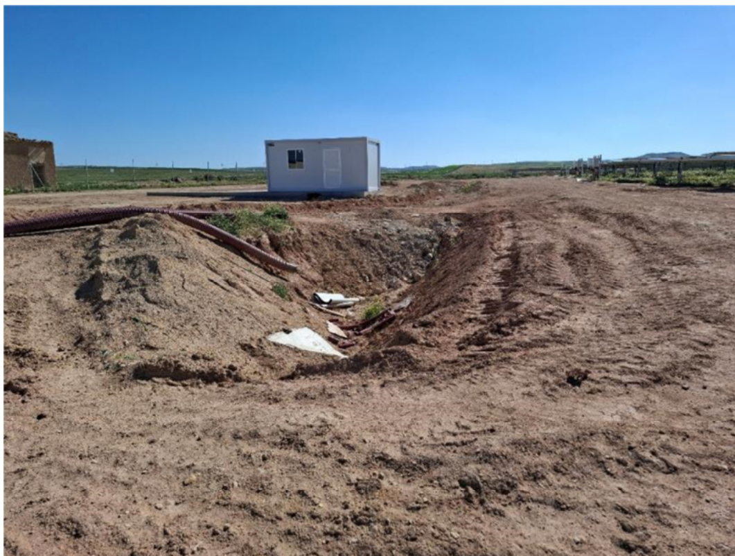
Figura 4.2. Caseta prefabricada sobre losa de hormigón y movimientos de tierra
