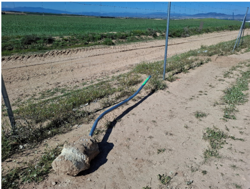
Figura 8.5. Poste doblado retirado, pendiente de sustitución.
