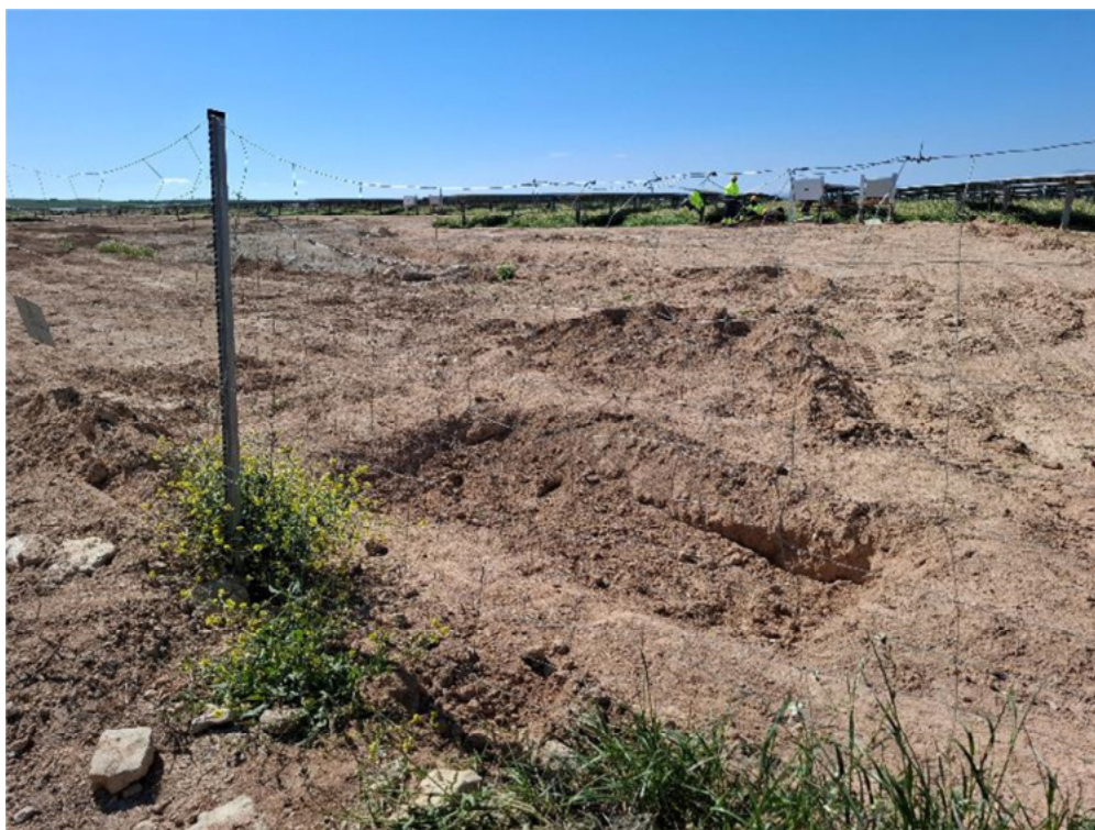
Figura 8.9. Vallado arreglado, aunque el arreglo presenta elementos punzantes y da lugar a la reducción puntual del tamaño de algunos cuadros del mismo
