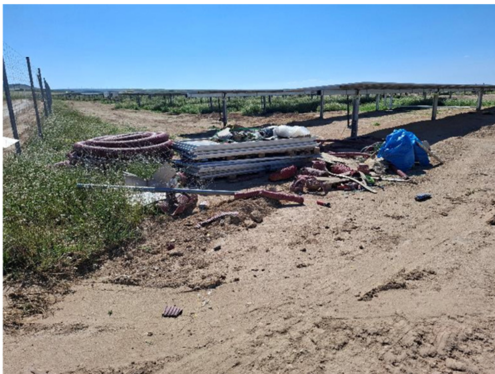
Figura 8.11. Acumulación de residuos puntual en el interior de la planta
