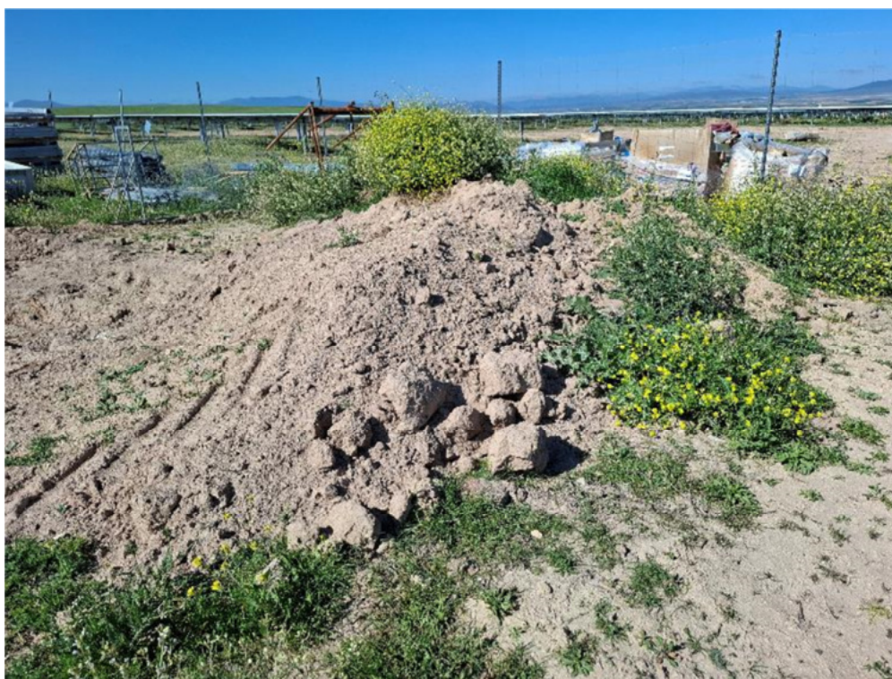
Figura 8.14. Acopio de tierra vegetal, sin balizar ubicado entre las plantas "San Pedro" y "Épila". Se han retirado los residuos que se situaban junto y sobre el mismo.
