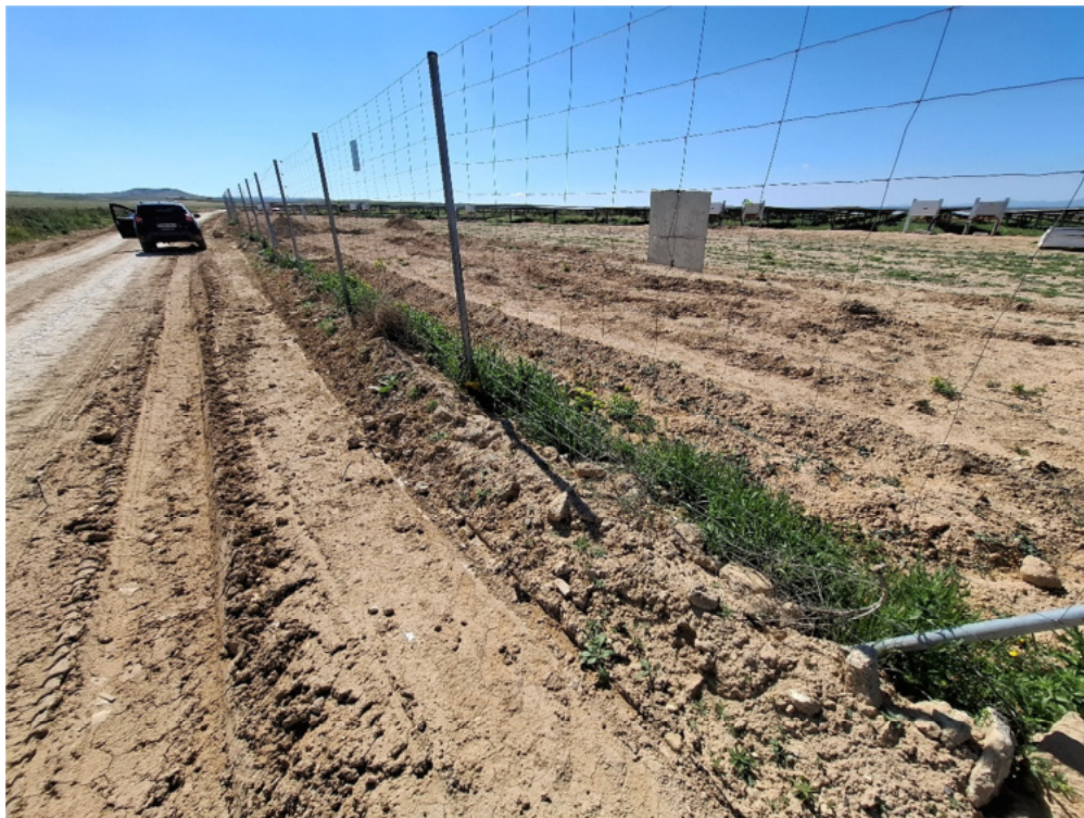
Figura 8.8. Obstrucción de un tramo largo del paso inferior de fauna en el límite norte del vallado, debido al sobrante de las tierras tras el cierre de las zanjas interiores
