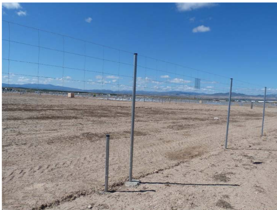
Figura 4.3. Placas instaladas y pasos de fauna abiertos en el vallado
