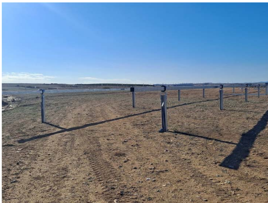
Figura 4.1. Instalación de las estructuras de soporte
