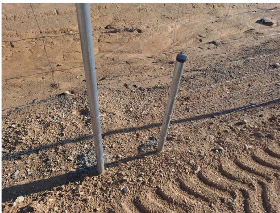
Figura 8.3. Pasos de fauna abiertos y tapones protectores colocados en los postes
