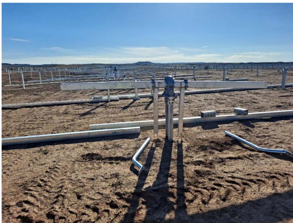
Figura 8.1. Montaje de las estructuras de soporte
