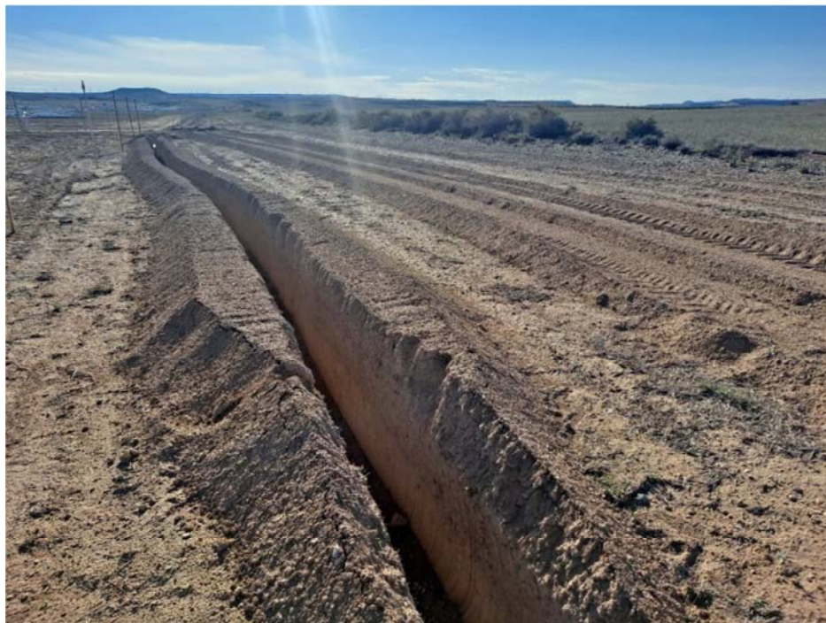
Figura 4.2. Zanjas para la instalación de la línea de evacuación entre "Épila" y "San Pedro"
