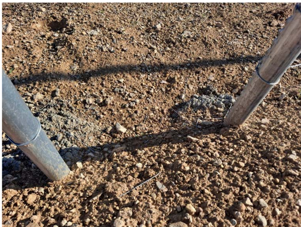
Figura 8.4. Detalle de los alambres que han quedado en el suelo debido a la apertura de los pasos de fauna
