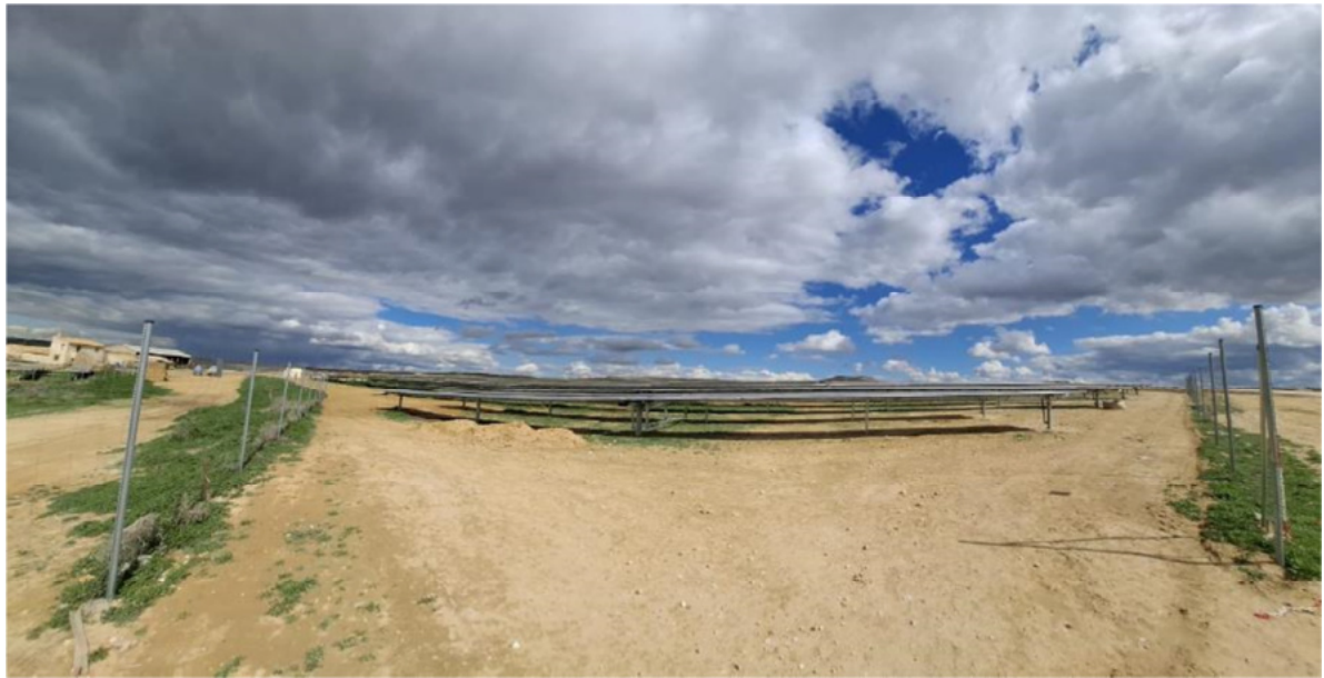
Figura 8.15. Aspecto de la planta “Épila 1”
