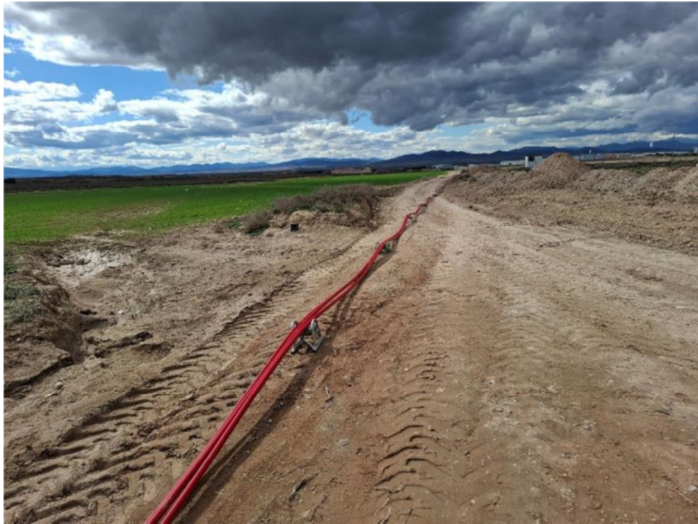
Figura 8.23. Instalación de cableado que corta puntualmente el camino de acceso, a la altura de “San Pedro B”.
