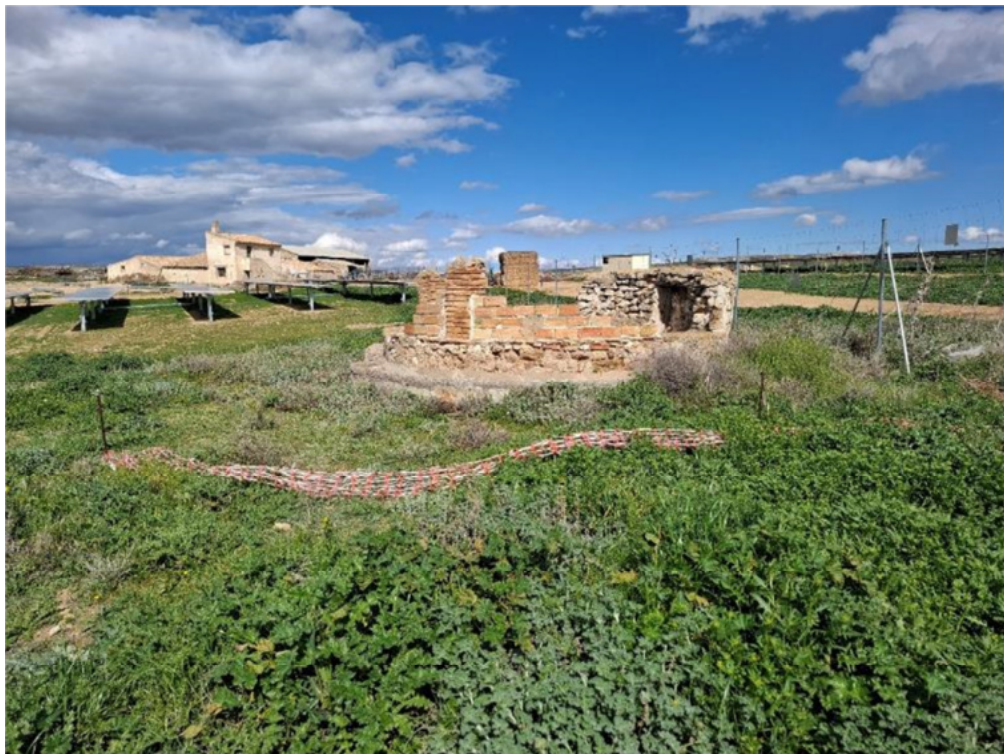
Figura 8.12. Balizado del pozo en el suelo, en la planta “Épila 2B”
