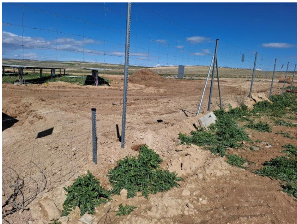
Figura 8.2. Obstrucción del paso inferior de fauna en el límite oriental del vallado de “Épila 3”
