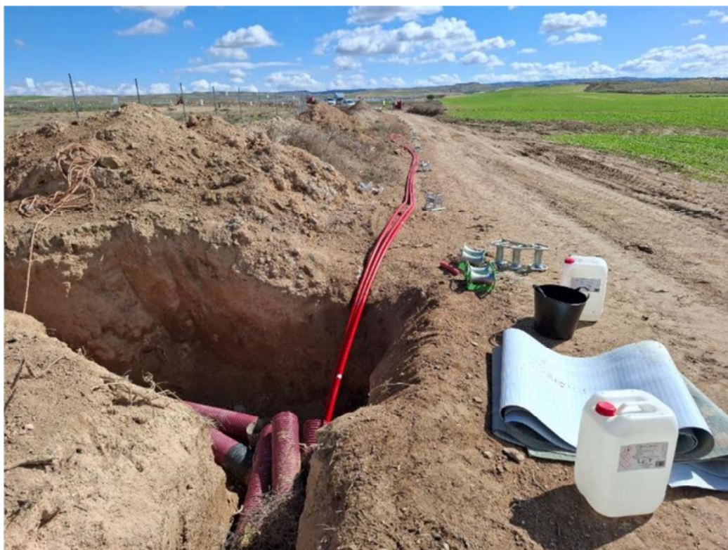
Figura 4.2. Colocación de cableado en zanja exterior
