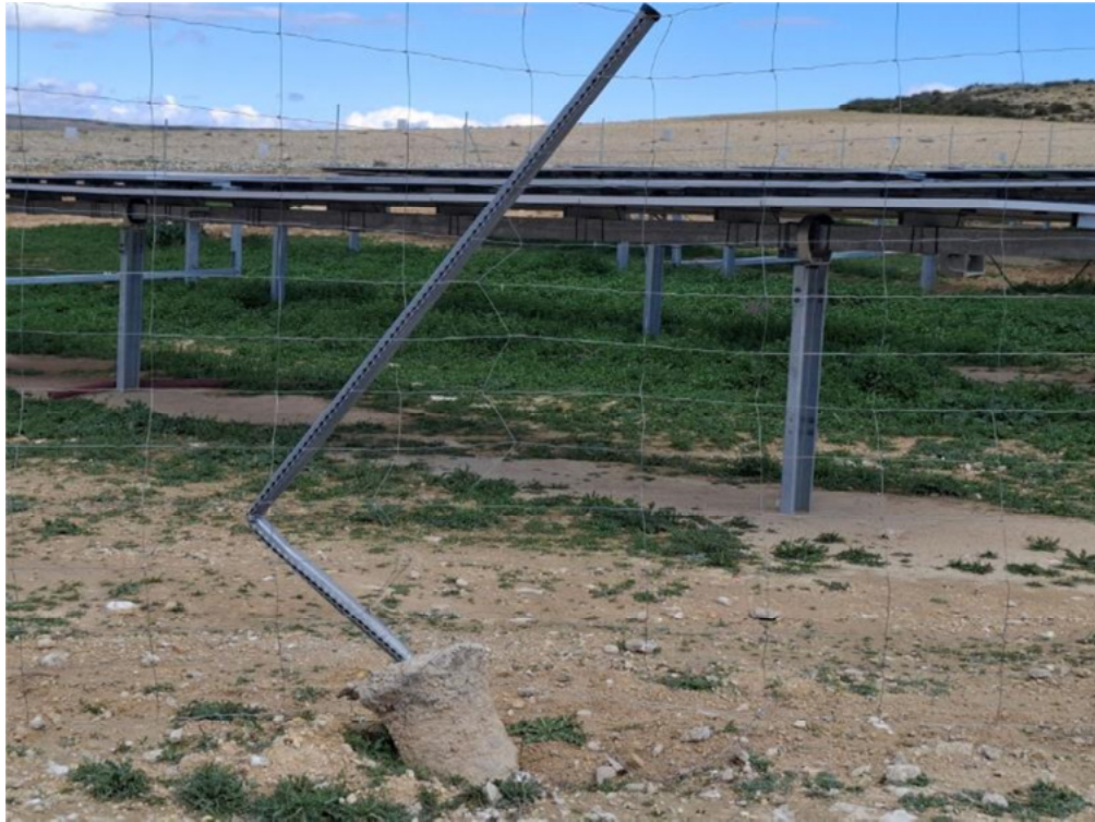
Figura 8.11. Poste doblado y vallado rodo en el extremo sur de la planta “Épila 2B”
