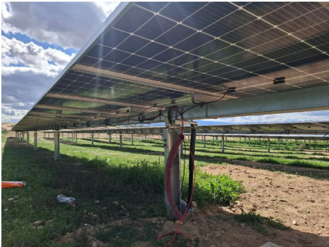
Figura 4.1. Instalación de cableado a lo largo de los seguidores en “Épila 2B”
