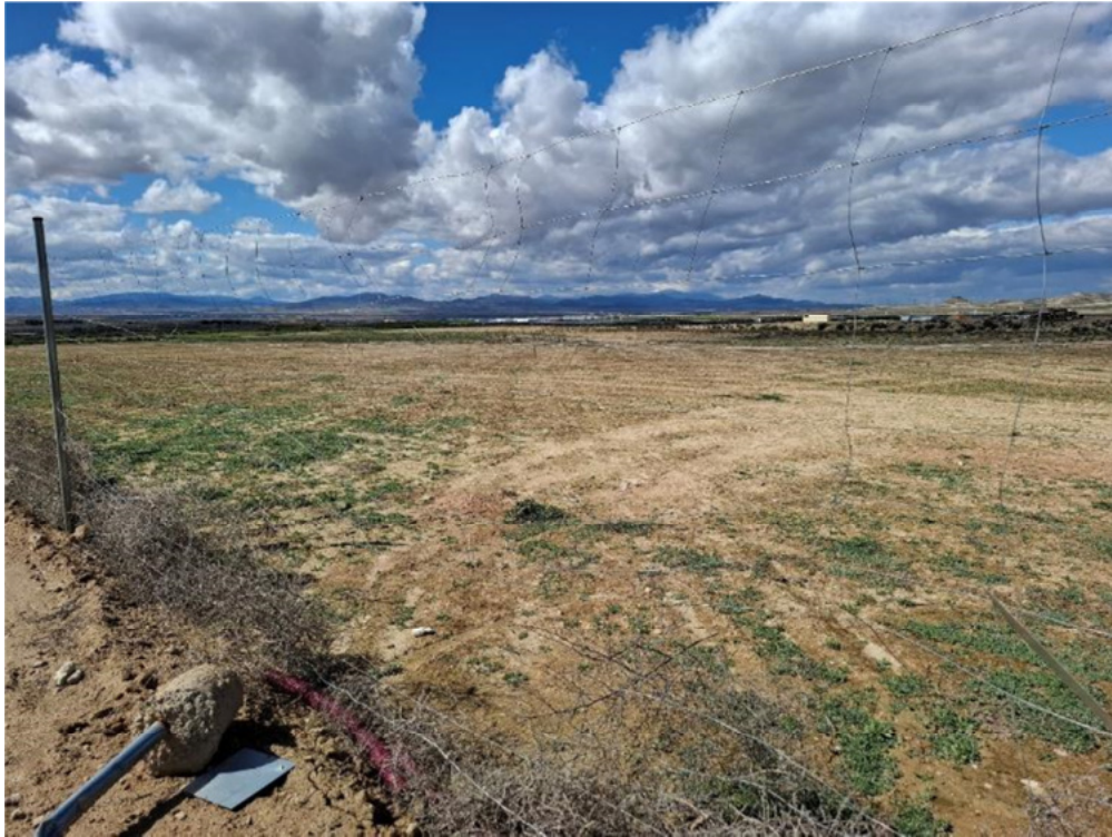
Figura 8.7. Vallado rodo generando alambres punzantes, peligrosos para la fauna, en “Épila 2A”. Además, la placa de visibilidad se encuentra en el suelo
