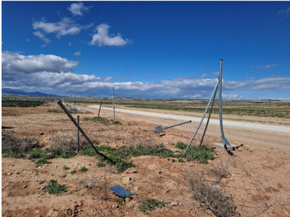
Figura 8.3. Vallado descolocado en la esquina noreste del recinto "Épila 3"
