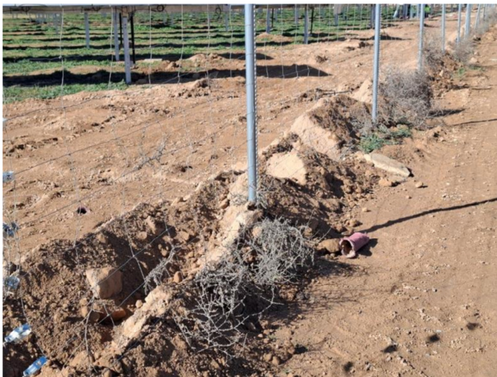
Figura 8.4. Obstrucción de un tramo del paso inferior de fauna en el extremo norte del vallado de “Épila 3”
