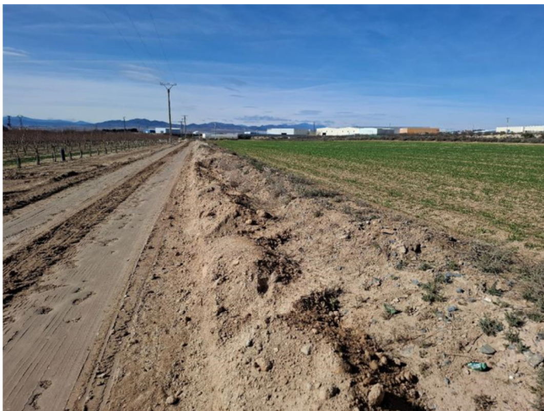
Figura 4.2. Zanja exterior cerrada
