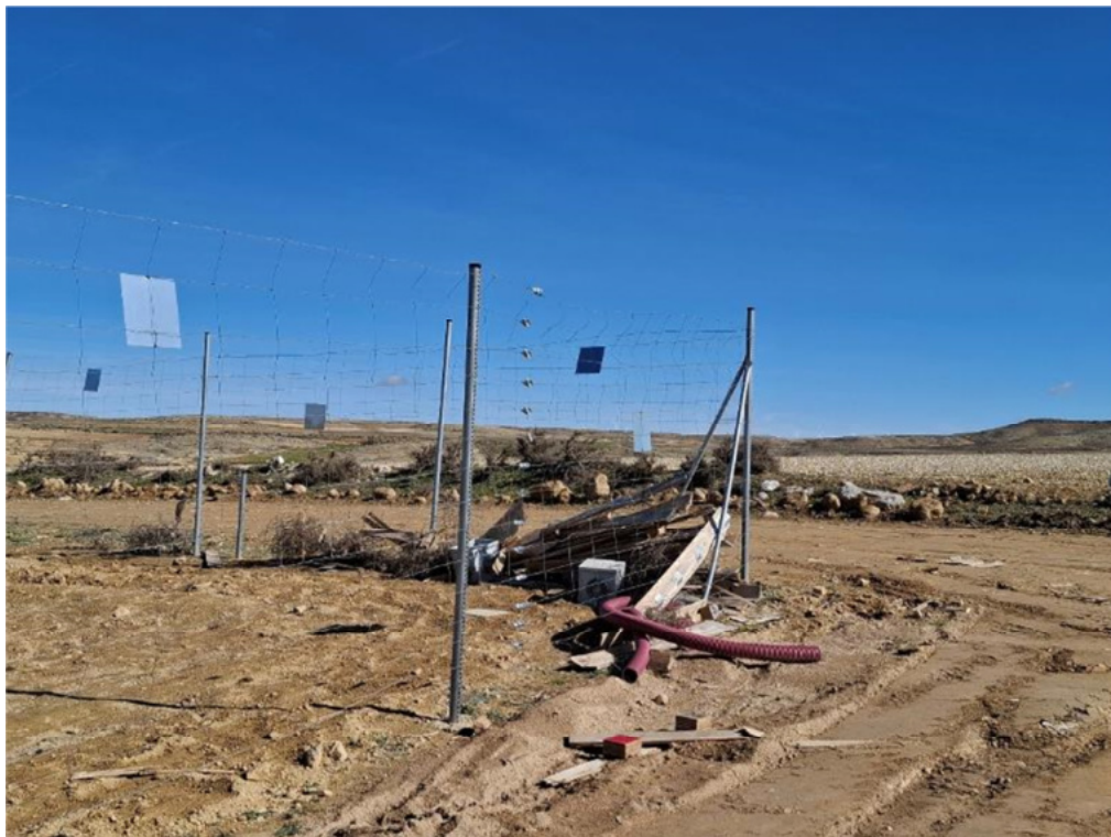
Figura 8.15. Acumulación de residuos en el extremo sureste de la planta “Épila 1”
