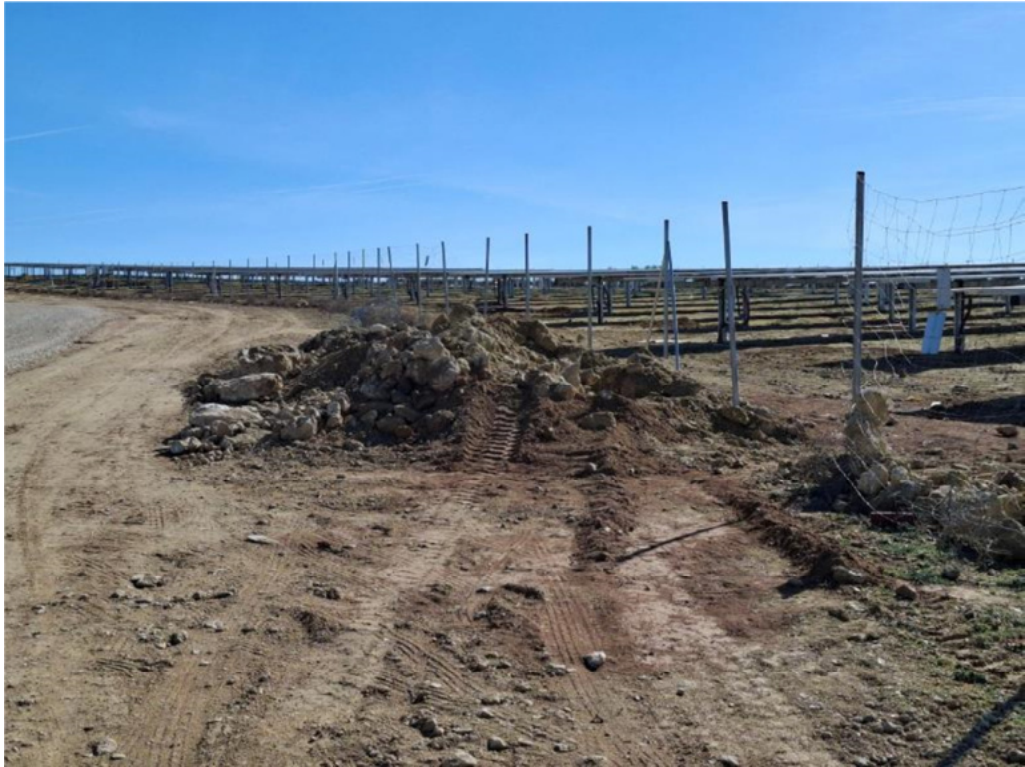
Figura 8.9. Acopio de tierras en el exterior de “Épila 2A”
