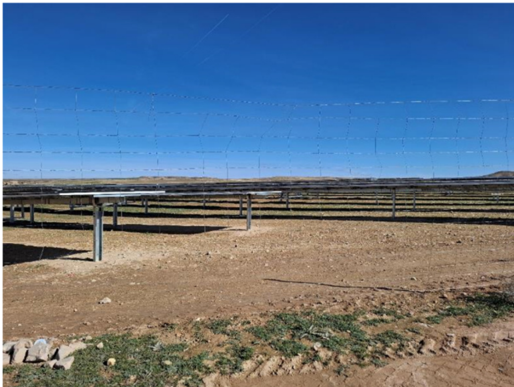
Figura 8.14. Placa ausente en un vano del vallado de “Épila 1”
