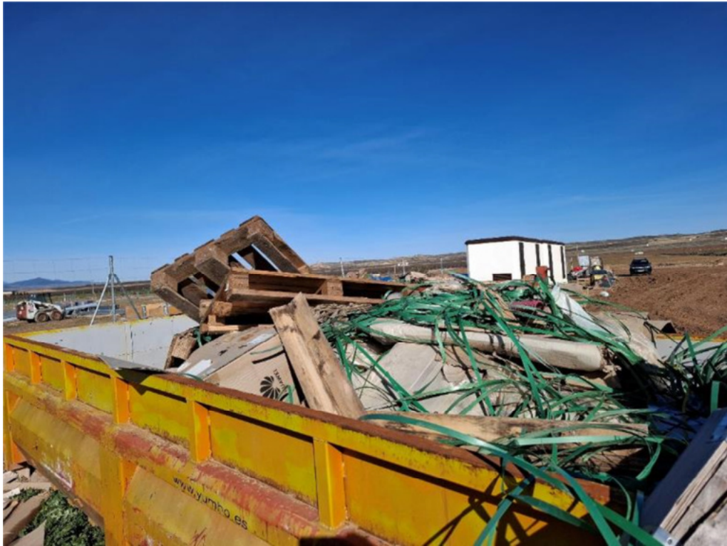
Figura 8.17. Residuos mezclados en el otro contenedor situado entre las plantas “Épila” y “San Pedro”
