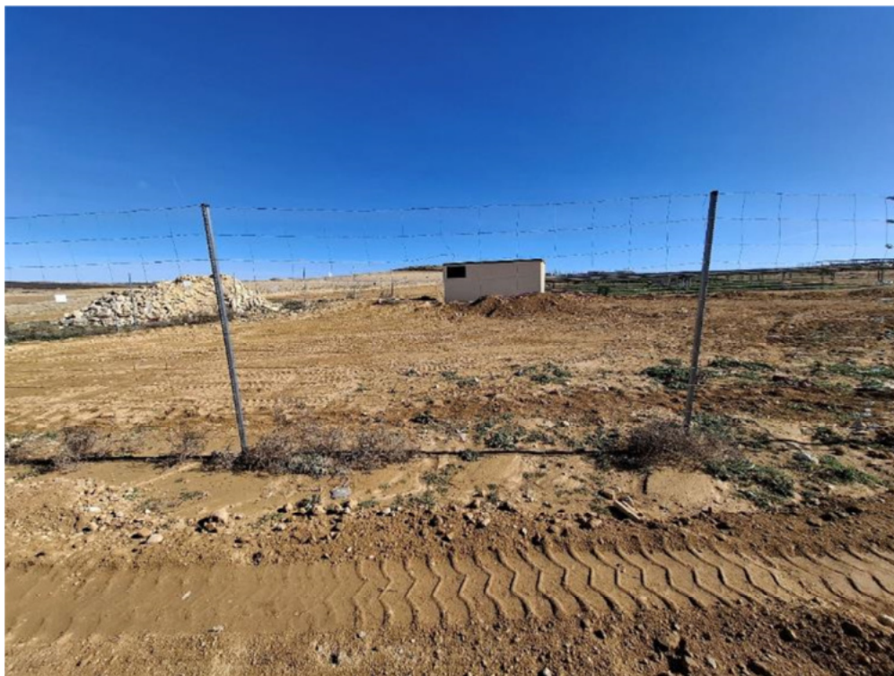
Figura 8.11. Placa ausente en un vano del vallado de “Épila 2B”
