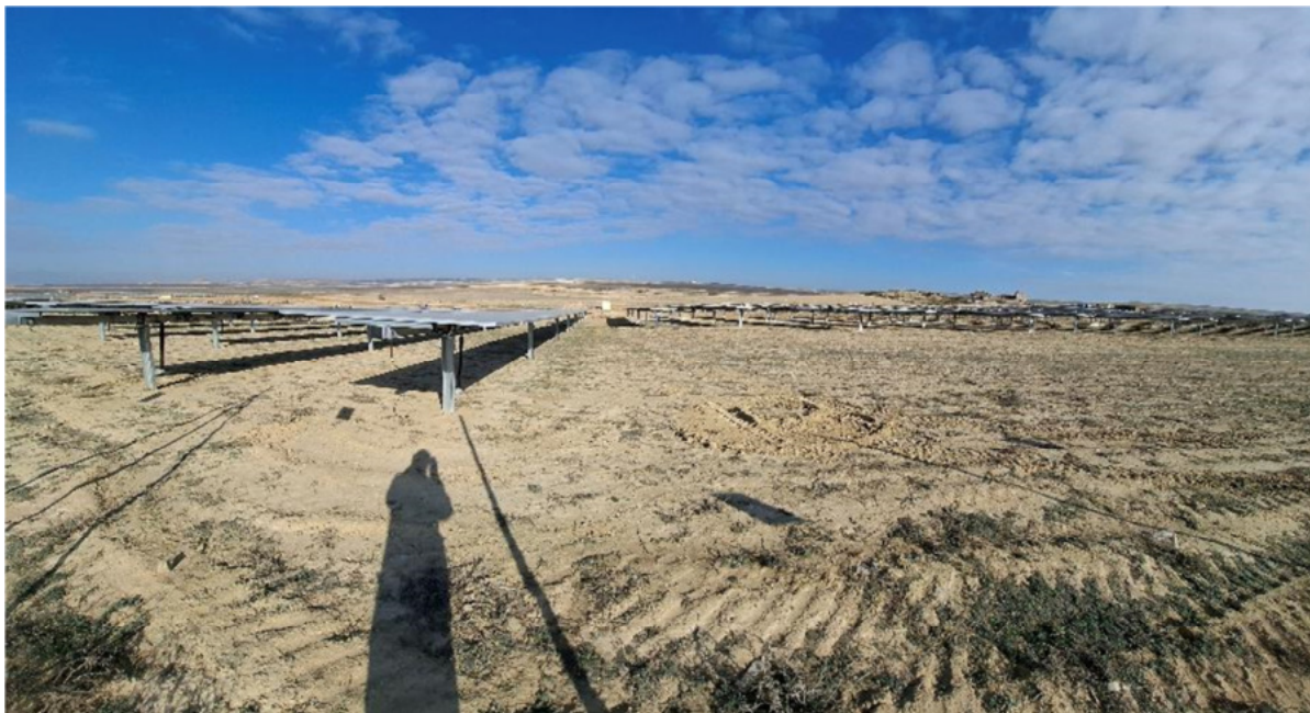
Figura 8.5. Aspecto general de “Épila 2A”
