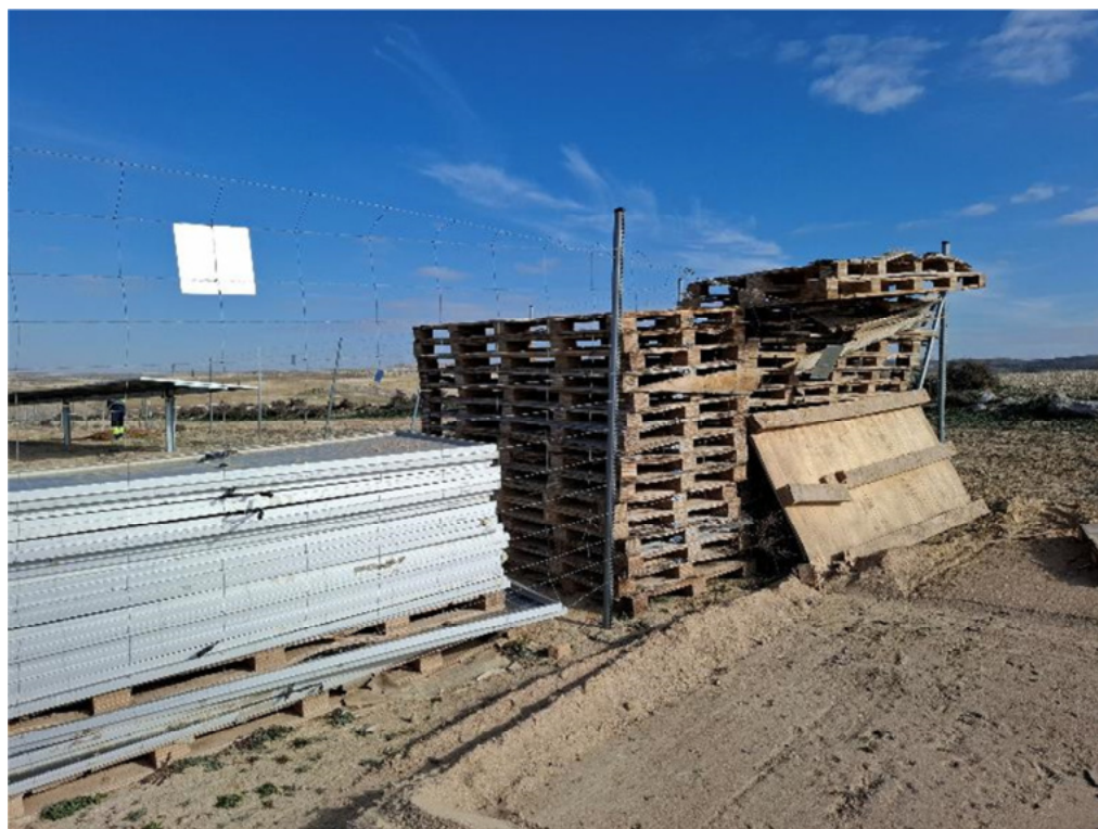
Figura 8.10. Acumulación de residuos en la esquina SE de “Épila 1”. Estos se encuentran apoyados contra el vallado, con riesgo de romperlo.
