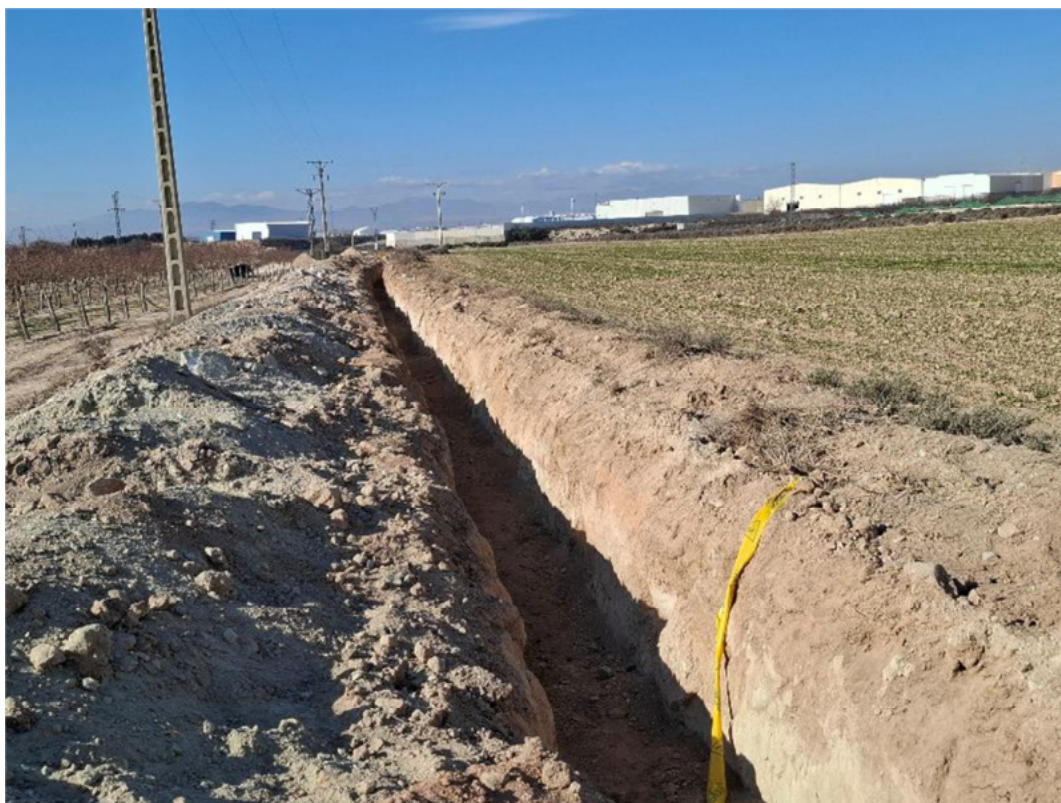
Figura 4.2. Zanja exterior abierta
