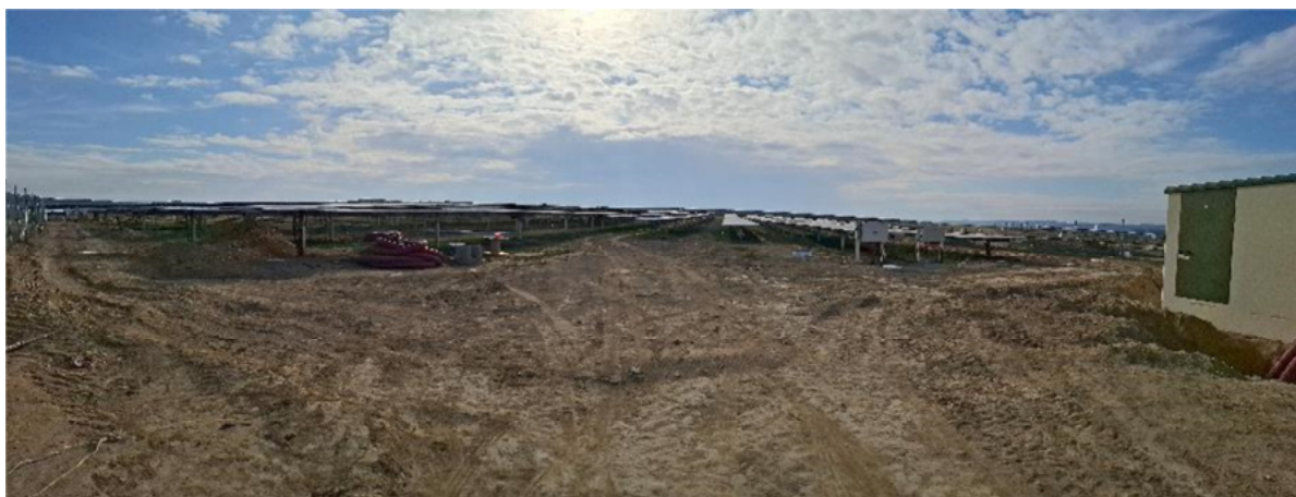
Figura 8.13. Aspecto de la planta “Épila 1”, con gran parte de las zanjas interiores tapadas
