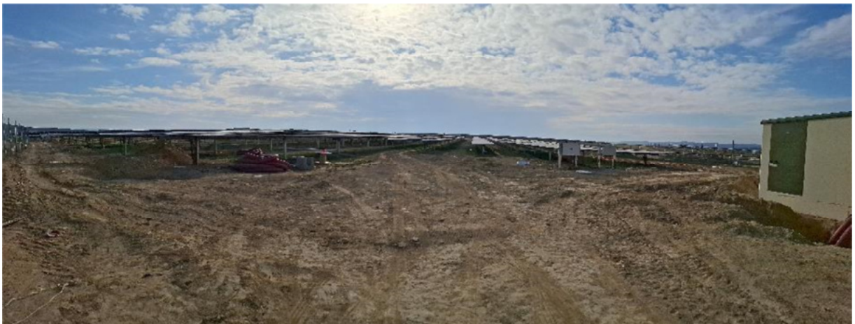
Figura 4.1. Aspecto del recinto “Épila 1”, con la mayor parte de las zanjas interiores ya cerradas
