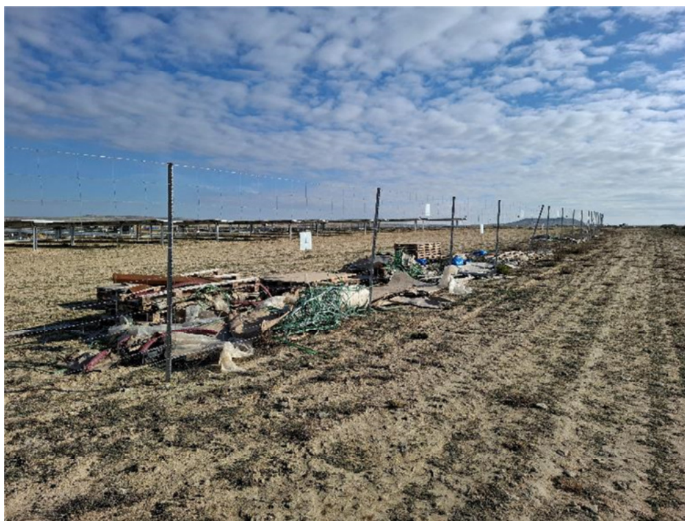
Figura 8.6. Acumulación de residuos y residuos dispersos en extremo sur de “Épila 2A”
