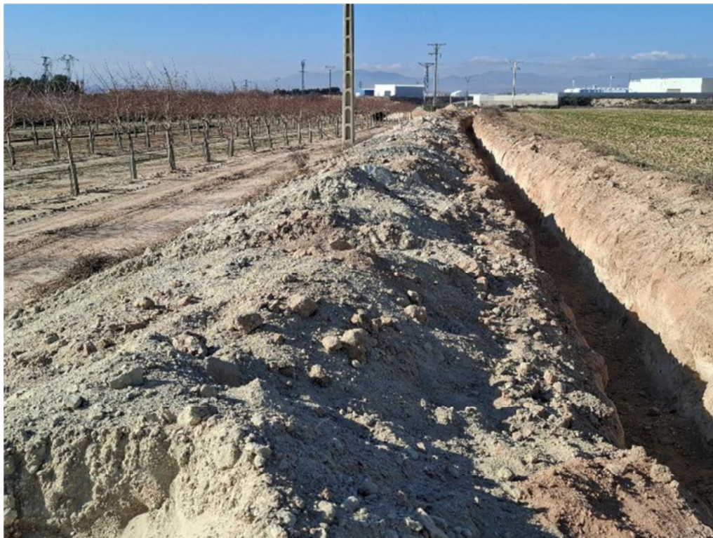
Figura 8.16. Zanja exterior alejada de los recintos de la planta. No se están separando la tierra vegetal del resto de las tierras
