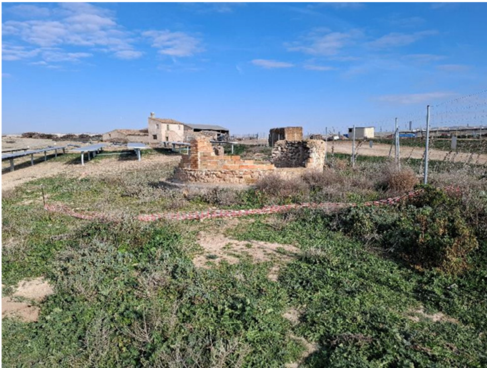
Figura 8.8. Balizado del pozo situado en “Épila 2B”, roto y en el suelo.
