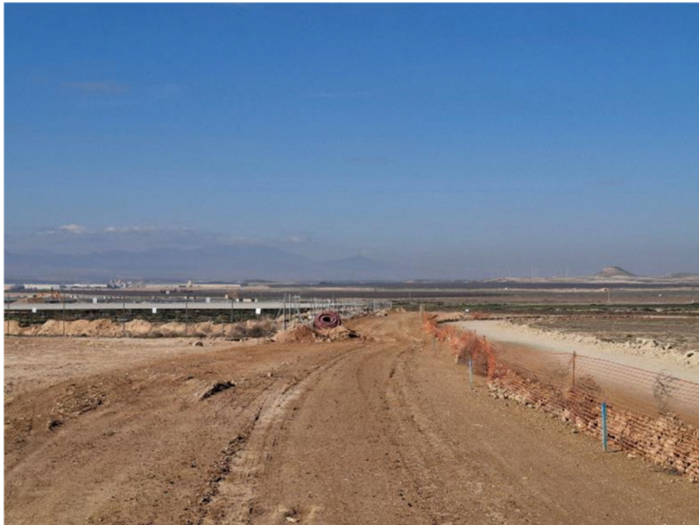
Figura 8.15. Zanja exterior a su paso por “Épila 3”, ya tapada
