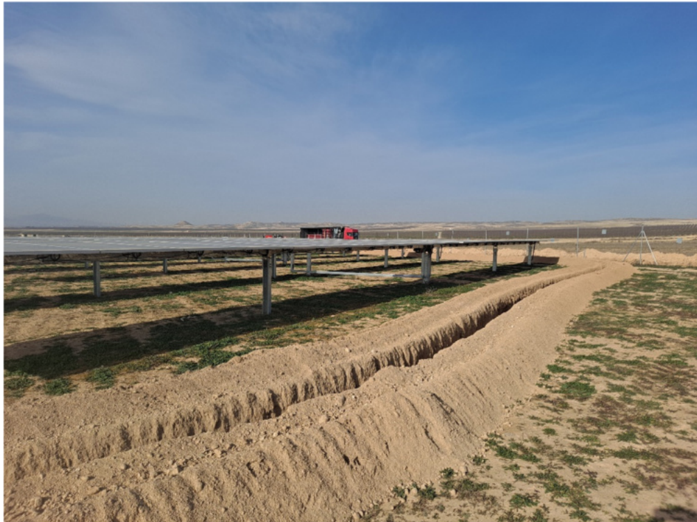
Figura 8.3. Apertura de zanjas interiores en “Épila 3”
