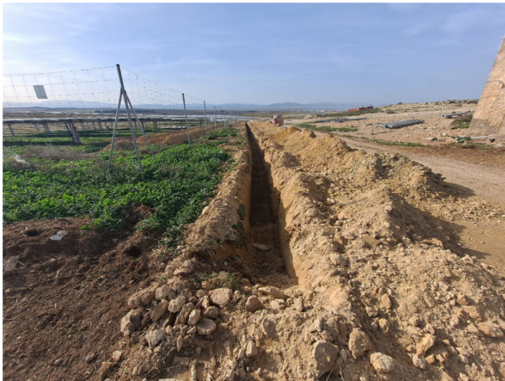
Figura 4.1. Apertura de zanjas exteriores junto a “Épila 2B”
