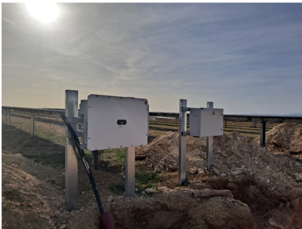
Figura 4.2. Colocación de inversores en "Épila 1"
