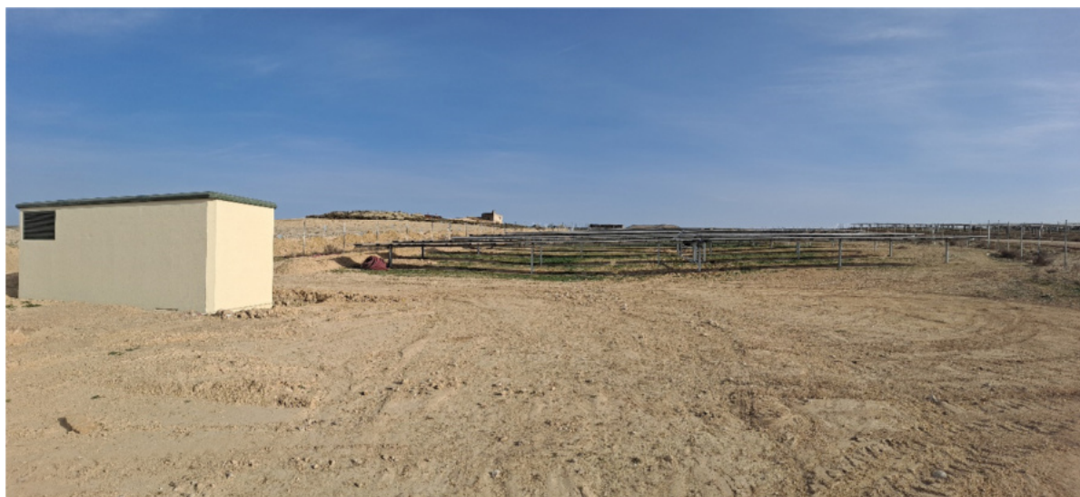
Figura 8.13. Aspecto de la planta “Épila 2B”
