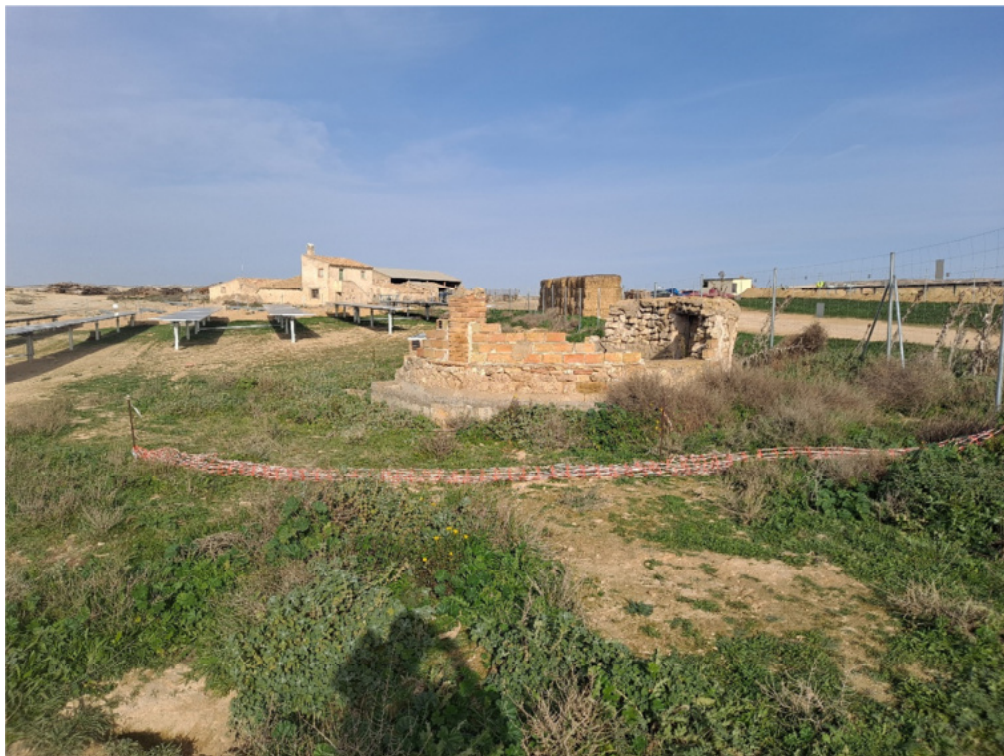
Figura 8.12. Balizado del pozo roto y en el suelo
