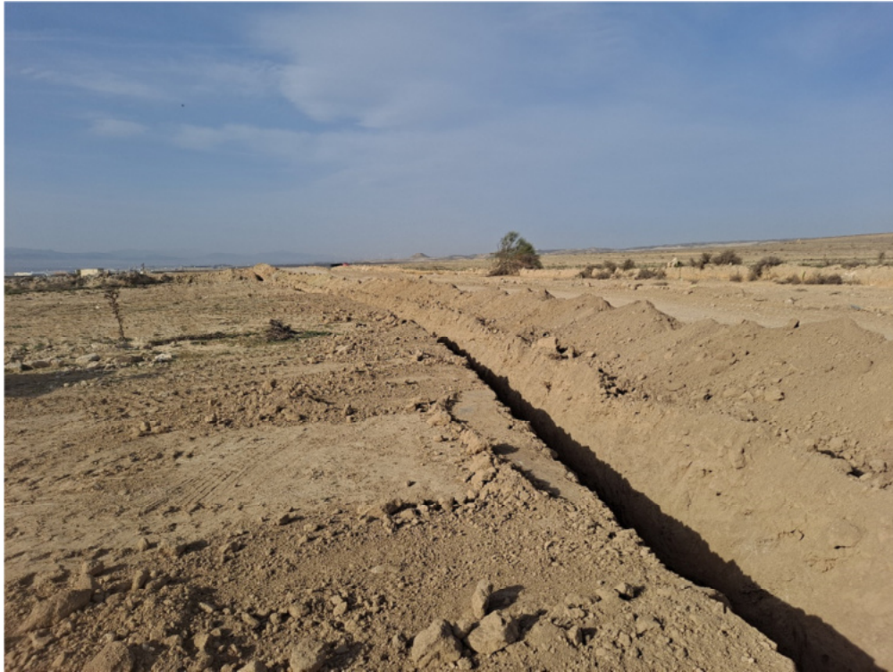
Figura 8.7. Zanja exterior, situada paralela al camino, en la zona entre “Épila 3” y “Épila 2A”. La tierra vegetal no se encuentra separada del resto de tierras
