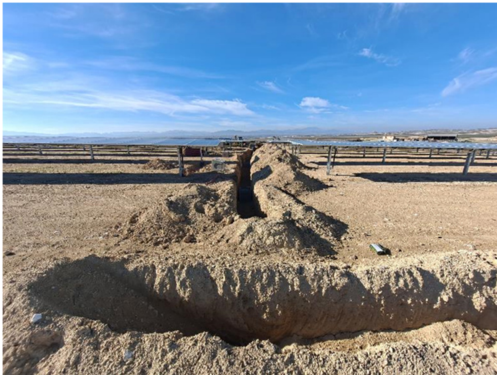
Figura 4.1. Apertura de zanjas interiores en el recinto “Épila 1”
