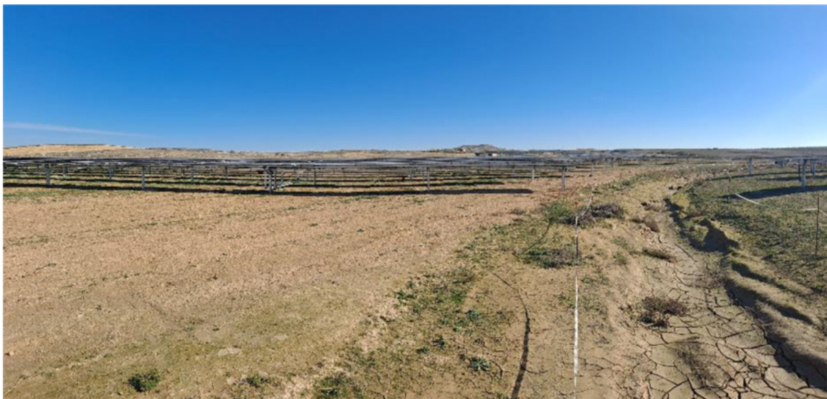
Figura 8.1. Aspecto de la planta “Épila 3”
