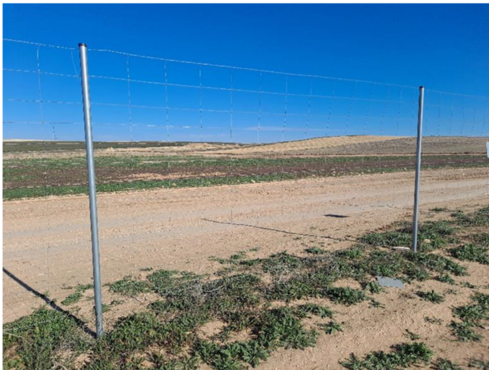
Figura 8.5. Vano sin placa de visibilidad en “Épila 3”
