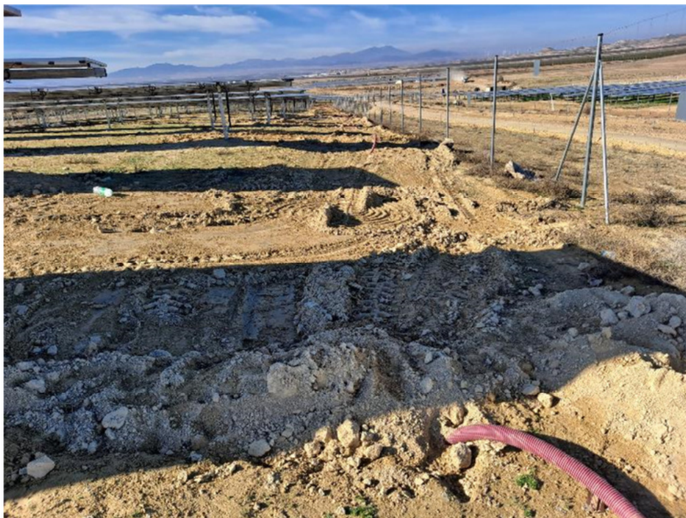
Figura 4.2. Cierre de zanja interior en el recinto “Épila 2A”
