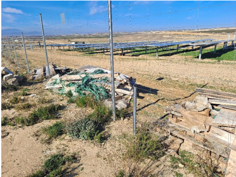
Figura 8.13. Residuos mezclados y acumulados en el margen sur de “Épila 2B”
