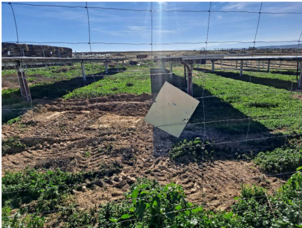
Figura 8.12. Placa sujeta por un único punto en “Épila 2B”
