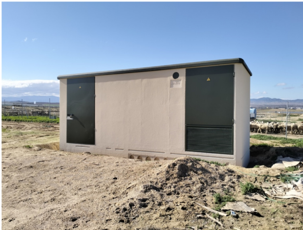
Figura 4.1. Instalación de CT en el recinto “Épila 1”
