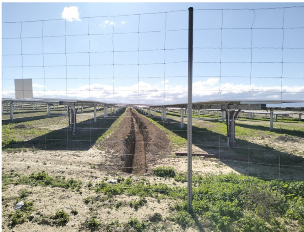
Figura 4.2. Apertura de zanja interior en el recinto “Épila 1”
