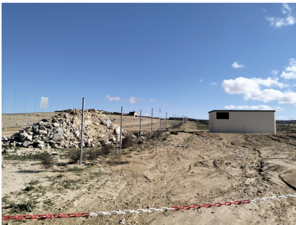
Figura 4.3. Instalación de CT en el recinto “Épila 2”
