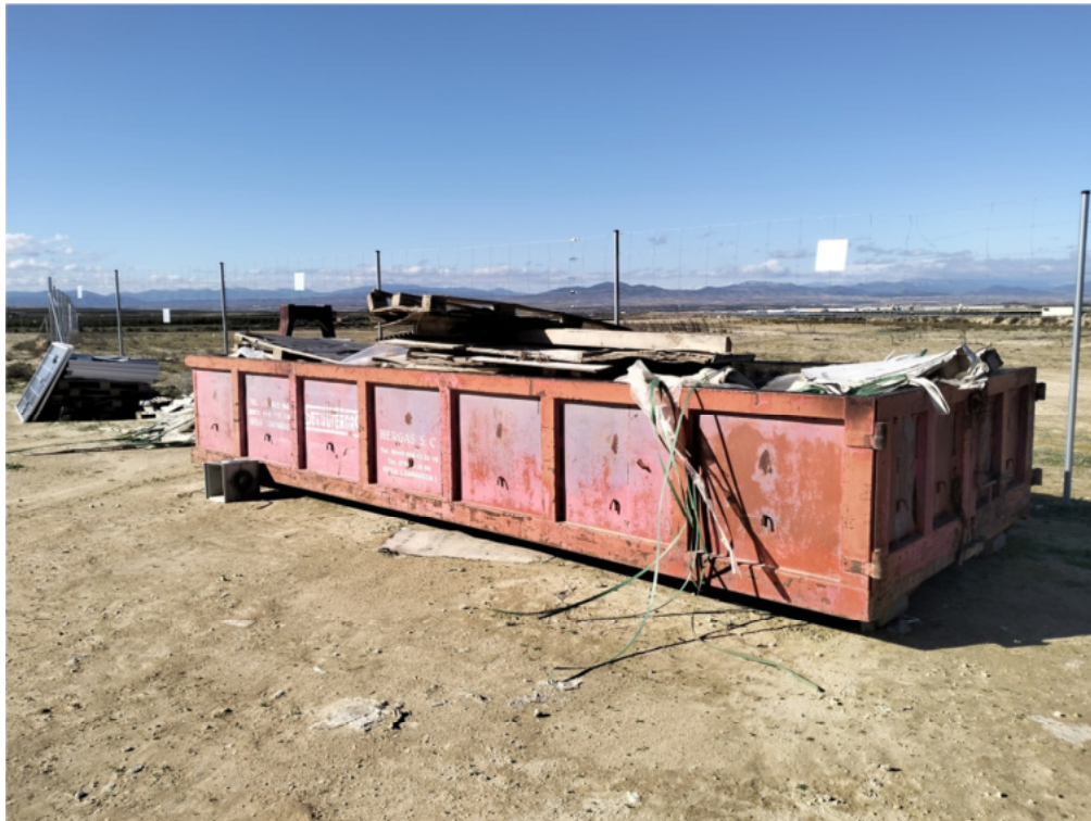
Figura 8.7. Contenedor de residuos situado en “Épila 2A”, con residuos mezclados.
