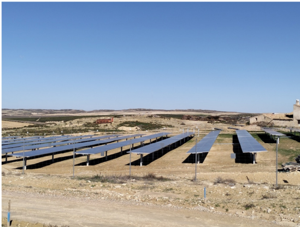
Figura 8.8. Aspecto de la planta “Épila 2B”
