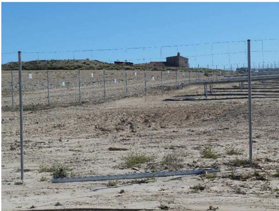
Figura 8.10. Ausencia de placa de visibilidad en el vallado en “Épila 2B”
