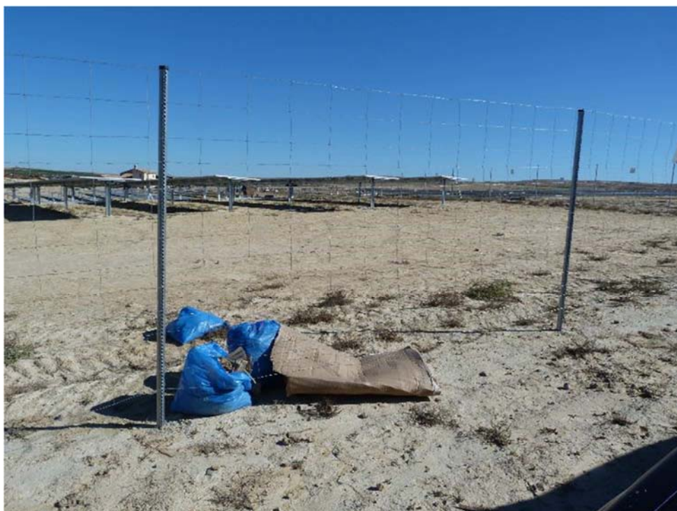
Figura 8.6. Ausencia de placa de visibilidad y residuos en bolsas y cartones en el suelo en “Épila 2A”
