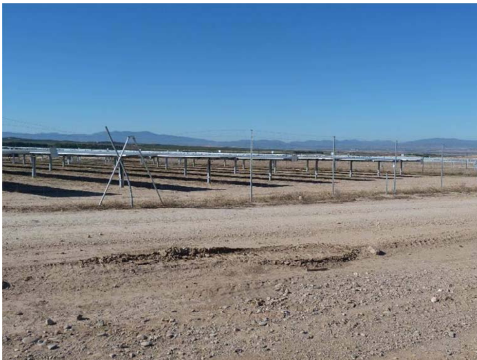
Figura 8.3. Vallado doblado y roto, que genera elementos punzantes en “Épila 3”
