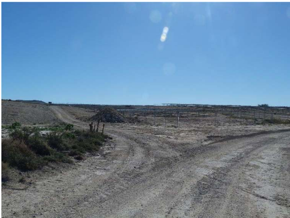
Figura 8.9. Aspecto de la planta “Épila 2B”
