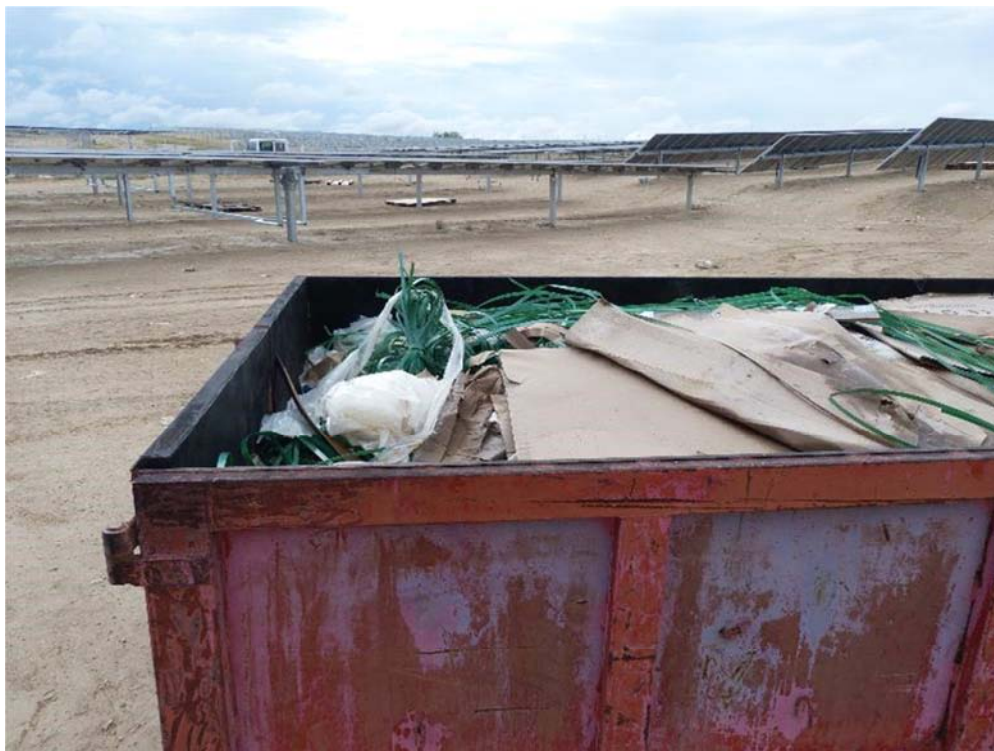
Figura 8.5. Contenedor instalado en “Épila 2A”. Presenta residuos mezclados.
