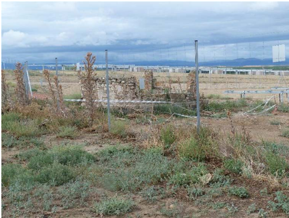
Figura 8.7. Balizado del pozo degradado, en la planta “Épila 2B”
