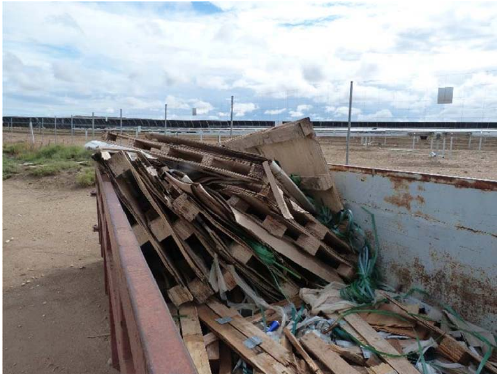
Figura 8.9. Residuos mezclados en el contenedor instalado en el exterior de “Épila 1”
