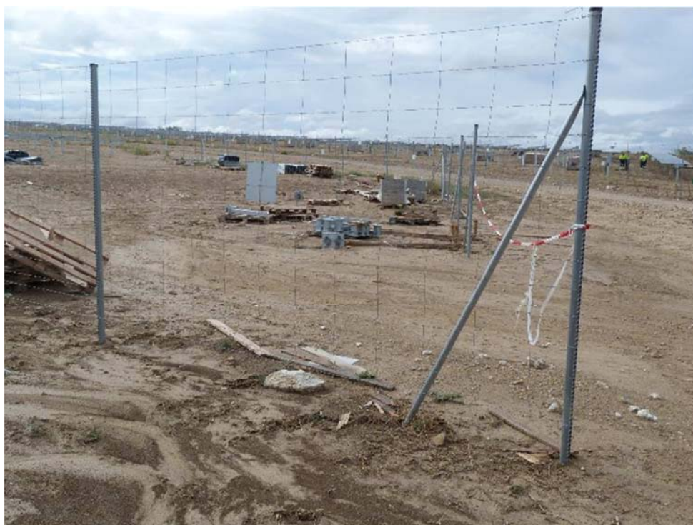
Figura 8.6. Residuos en la entrada de la planta en “Épila 2B”
