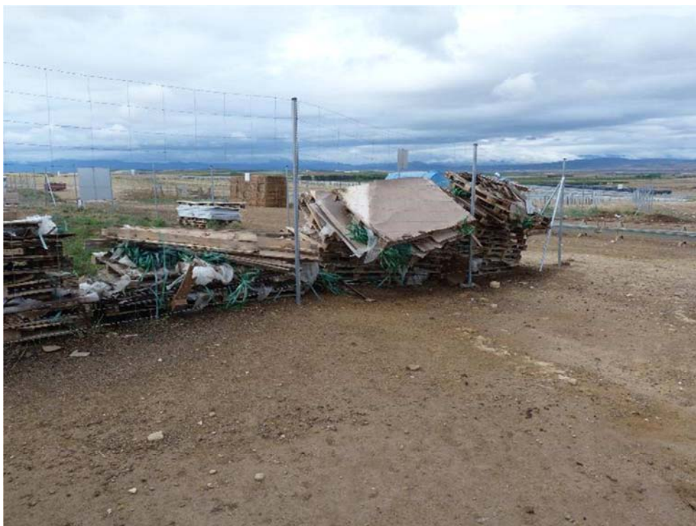
Figura 8.8. Acumulaciones de residuos fuera de los contenedores, en “Épila 1”
