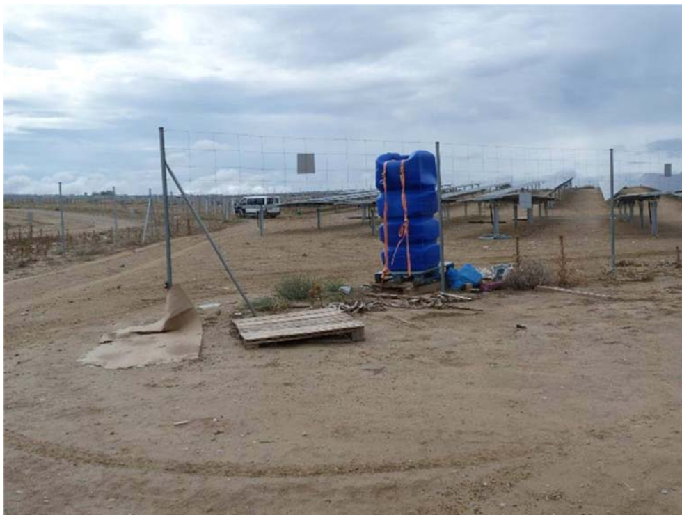
Figura 8.3. Residuos en el suelo (cartones) en la entrada de la planta “Épila 2A”
