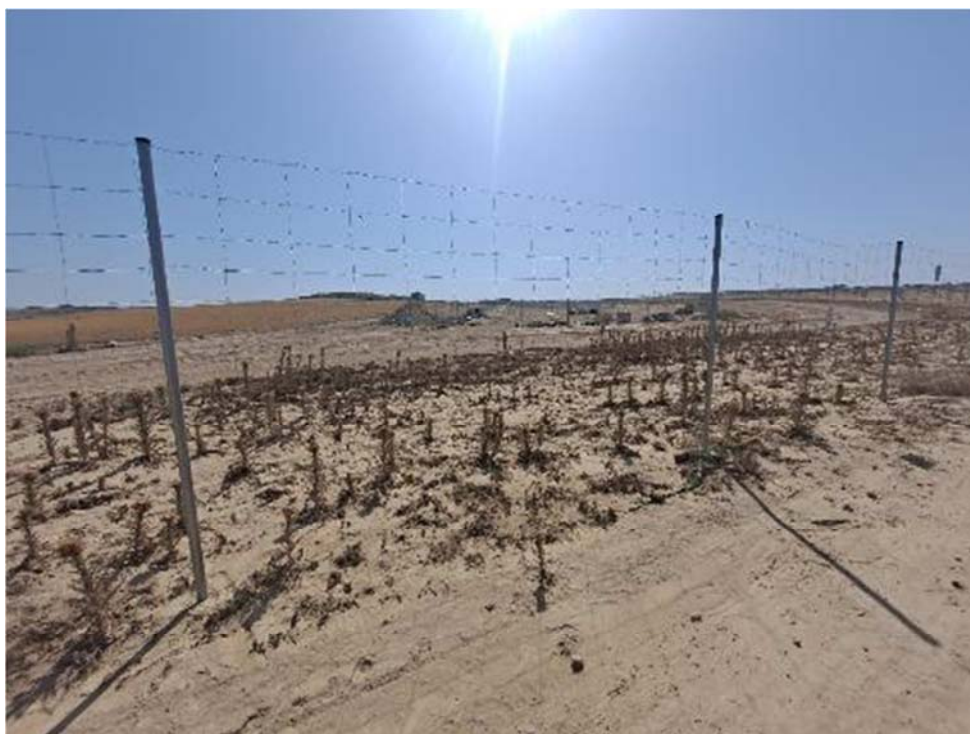
Figura 8.6. Ausencia de placa de visibilidad en “Épila 2A”
