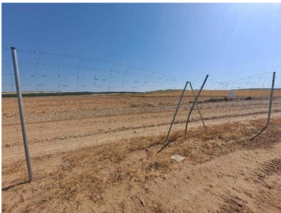
Figura 8.3. Tramo del vallado roto en “Épila 3”, con elementos punzantes peligrosos para la fauna
