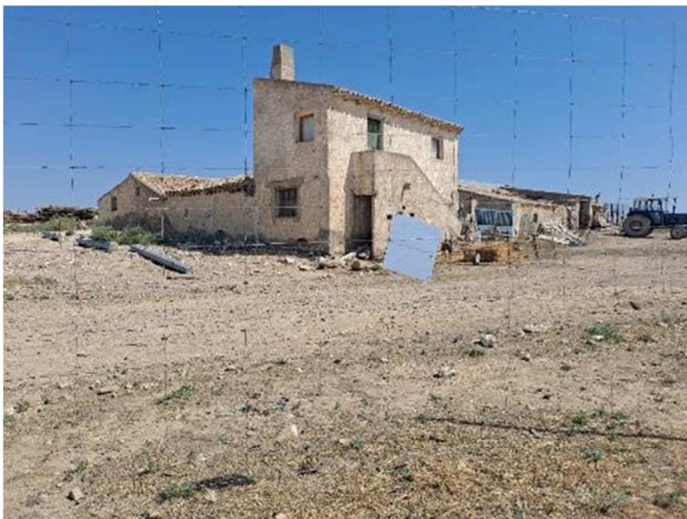
Figura 8.12. Placa con un solo punto de anclaje en “Épila 2B”
