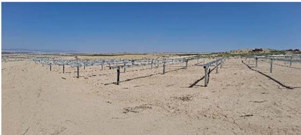
Figura 8.10. Aspecto del recinto “Épila 2B”, con los soportes verticales y seguidores colocados
