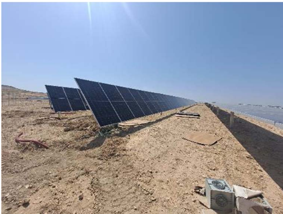
Figura 8.16. Aspecto de la planta “Épila 1”, donde se están colocando placas solares
