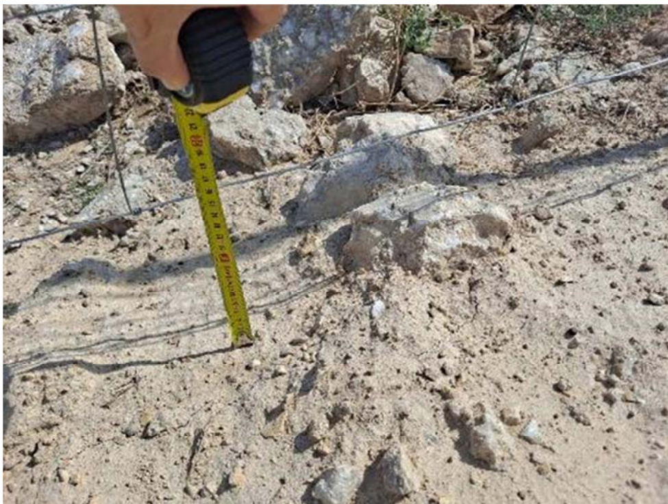
Figura 8.11. Paso inferior de fauna en el vallado, a la altura del primer ribazo. Se han retirado las tierras que lo obstruían, quedando una altura de 15 cm.
