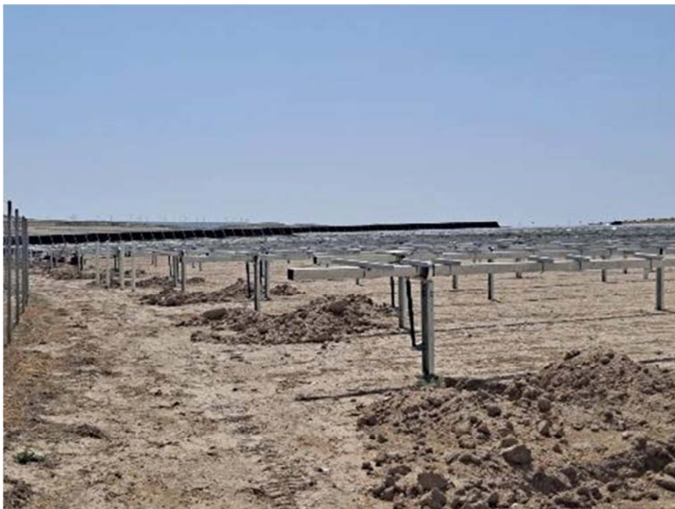
Figura 8.17. Pequeñas excavaciones realizadas junto a los postes verticales, en “Épila 1”
