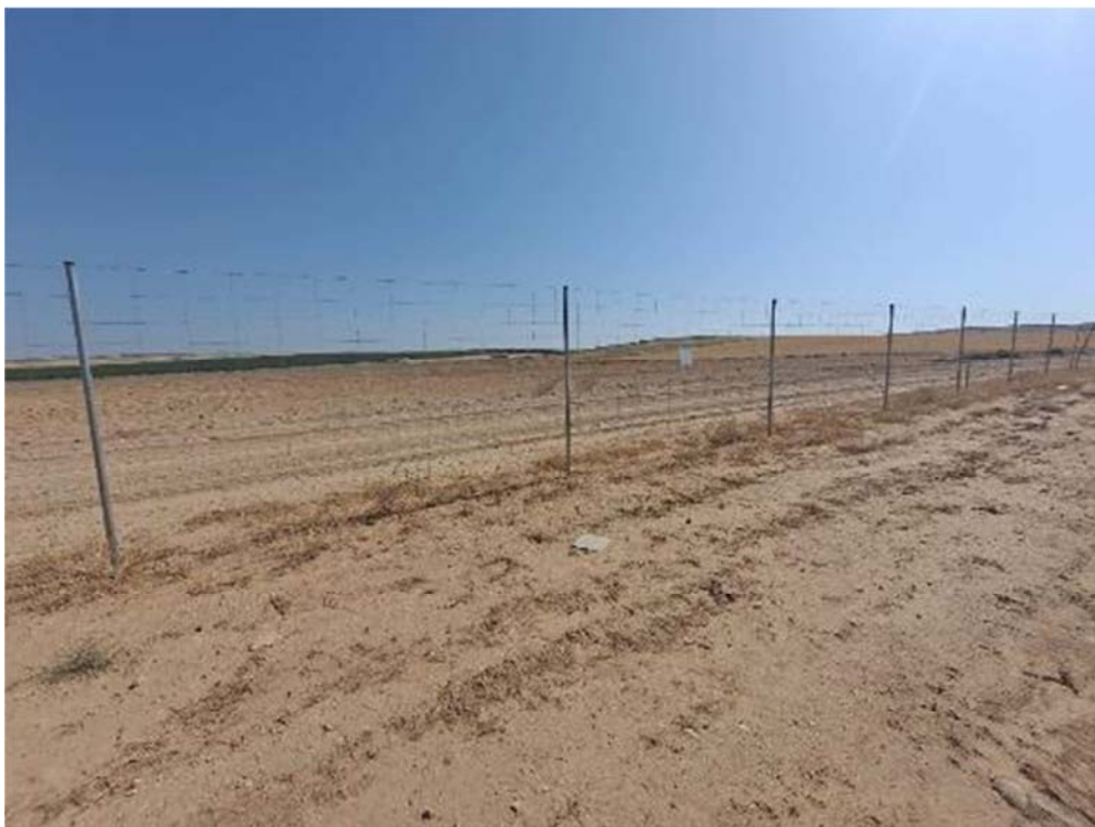
Figura 8.2. Ausencia de dos placas de visibilidad en la planta “Épila 3”
