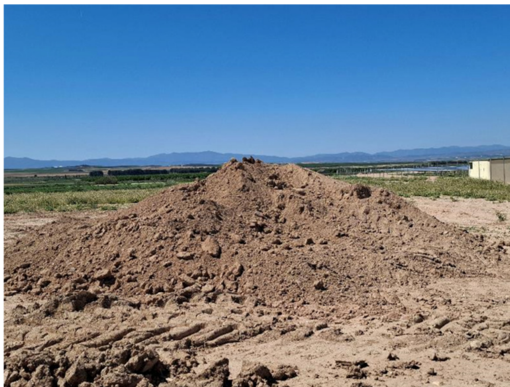
Figura 8.6. Acopio de tierras donde no se ha separado la tierra vegetal, en los terrenos situados entre “Épila 3” y “Épila 2A”
