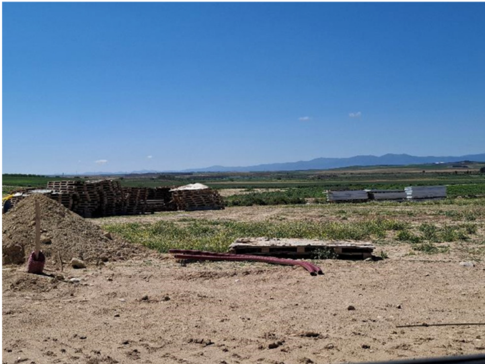
Figura 8.7. Acumulación de placas, palés y otros residuos, en los terrenos situados entre “Épila 3” y “Épila 2A”
