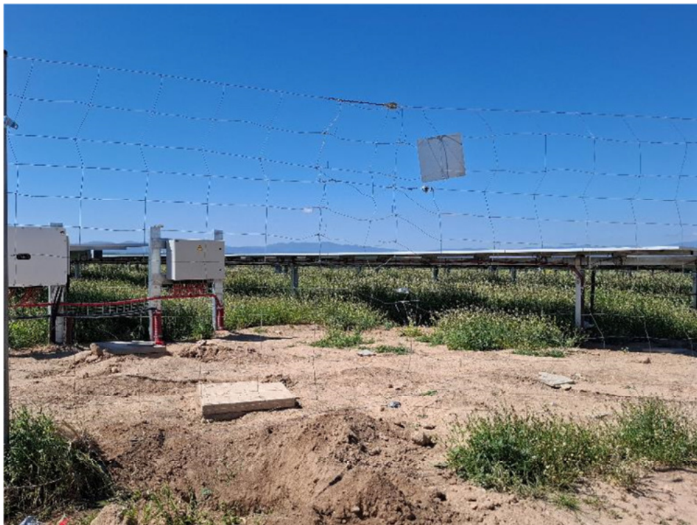
Figura 8.4. Vallado arreglado en "Épila 3", aunque el arreglo presenta elementos punzantes y da lugar a la reducción puntual del tamaño de algunos cuadros del mismo
