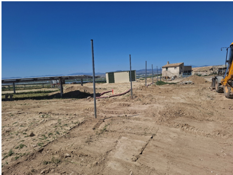
Figura 4.2. Zona norte del recinto “Épila 1” donde se ha desmontado un tramo del vallado para su sustitución
