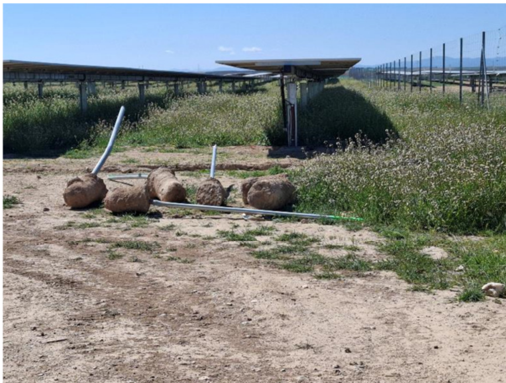
Figura 8.5. Postes doblados retirados del vallado de “Épila 3”, pendientes de sustitución
