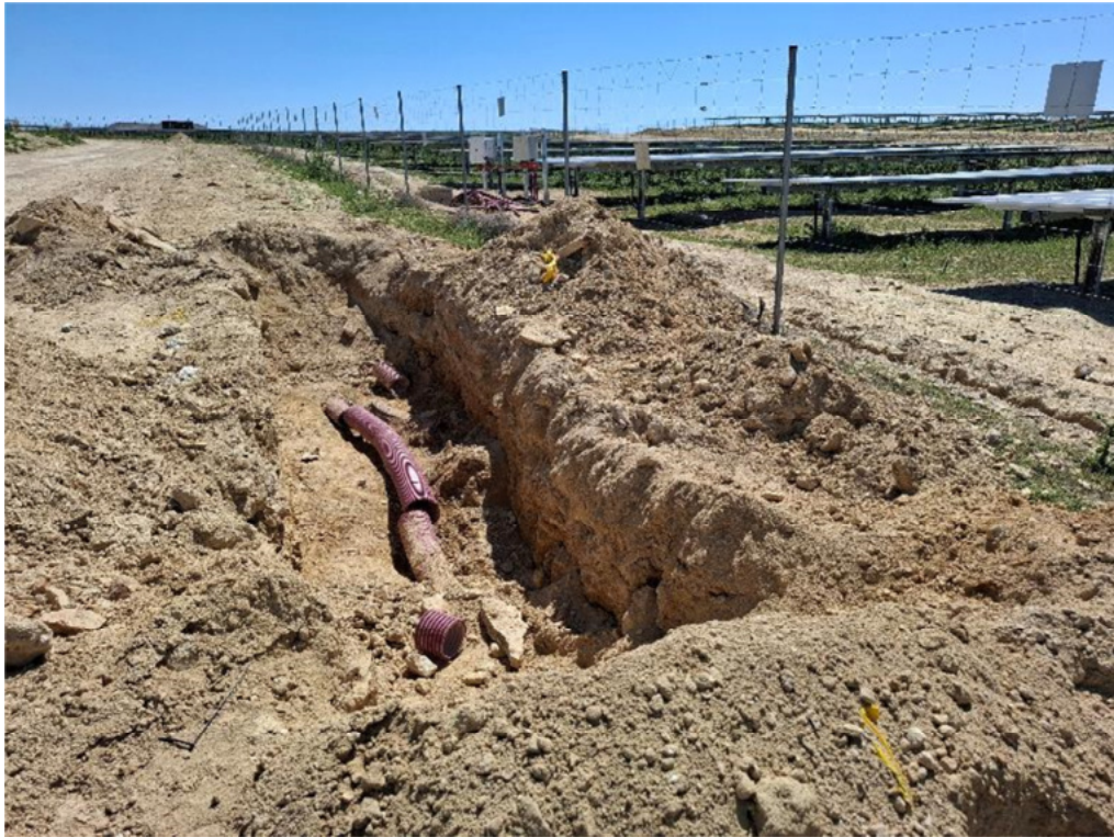
Figura 8.14. Zanja excavada en el exterior norte de “Épila 2B”. La tierra vegetal no se ha separado del resto de tierras
