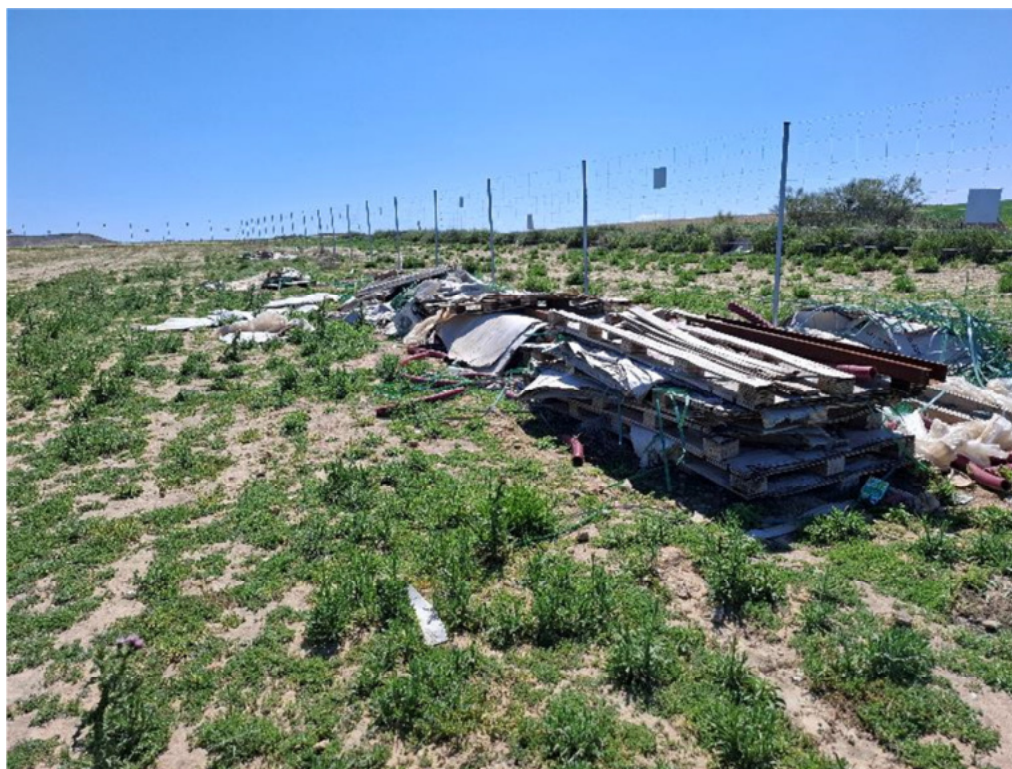
Figura 8.10. Acumulación de residuos en el extremo suroriental de la planta “Épila 2A”
