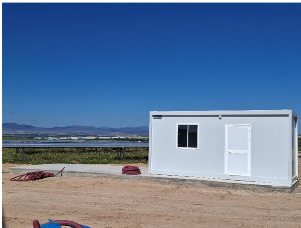
Figura 4.3. Caseta prefabricada sobre losa de hormigón
