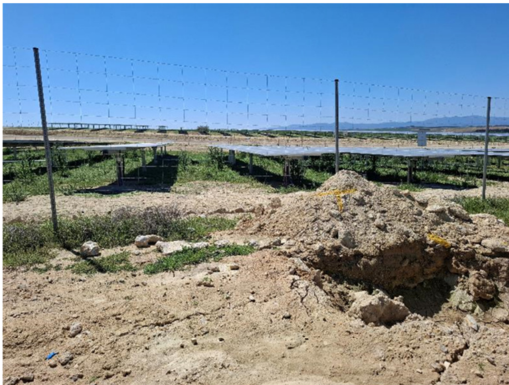
Figura 8.14. Placa ausente en un vano del vallado de “Épila 2B” y paso inferior de fauna obstruido por el acopio de tierras
