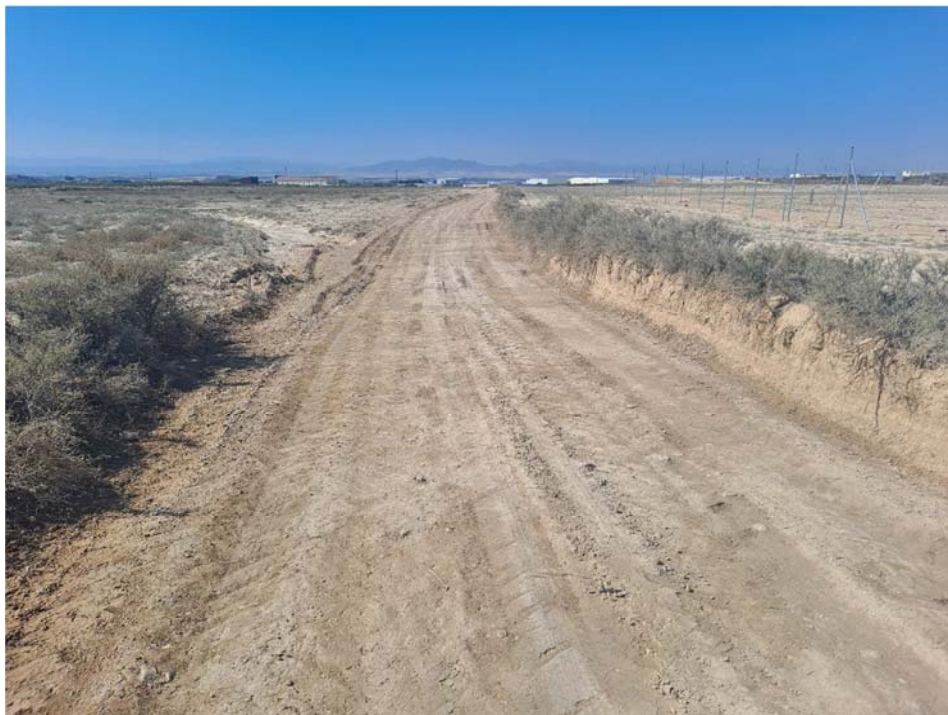
Figura 8.5. Tramo del camino de acceso donde se han realizado arreglos
