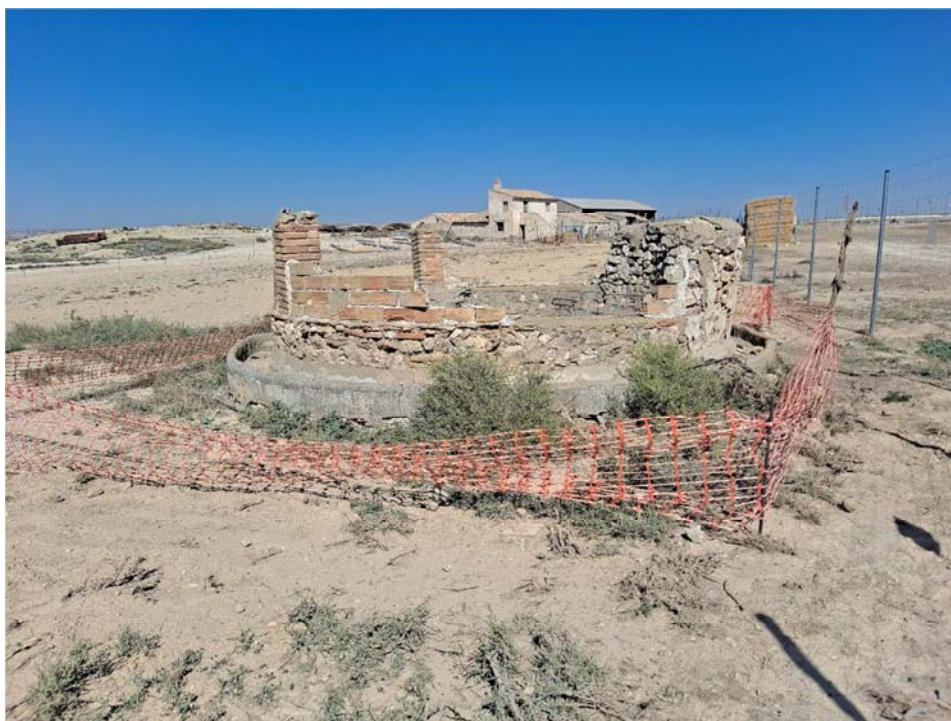
Figura 8.4. Balizado del pozo localizado en la planta “Épila 2B”, en buen estado
