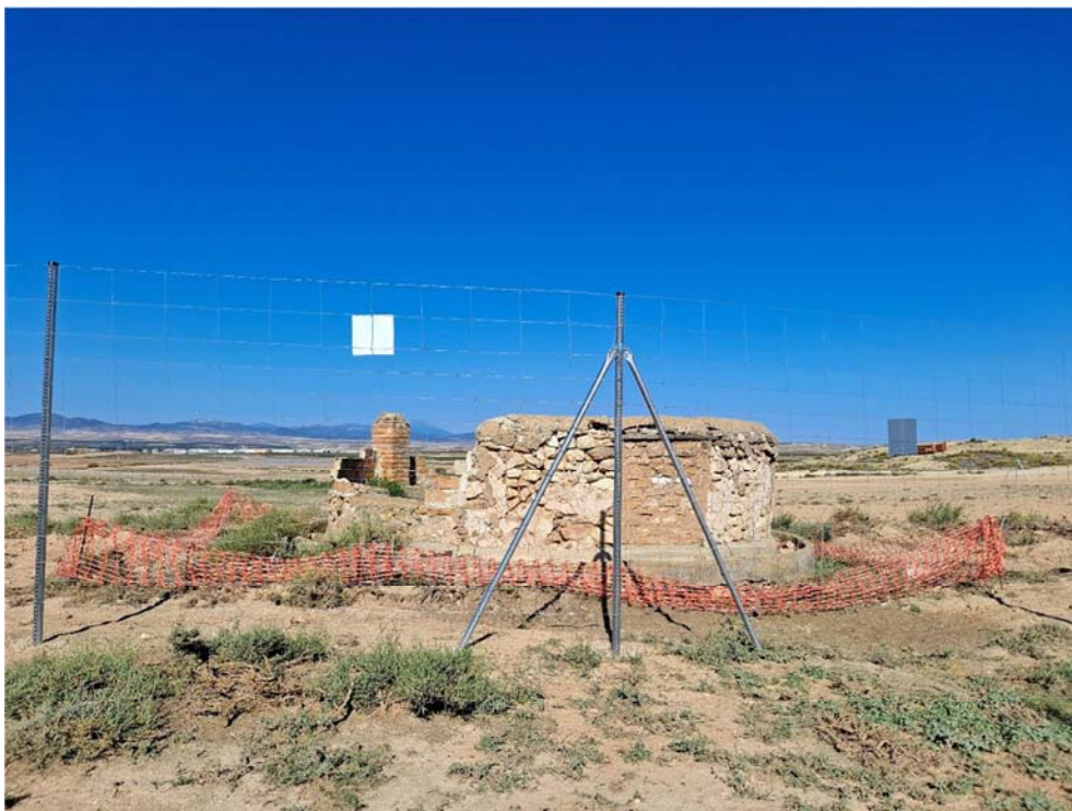
Figura 8.7. Pozo balizado correctamente, situado en la planta “Épila 2B”
