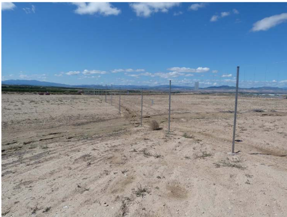
Figura 8.3. Vallado en la planta “Épila 3”, con las placas instaladas y pasos de fauna abiertos
