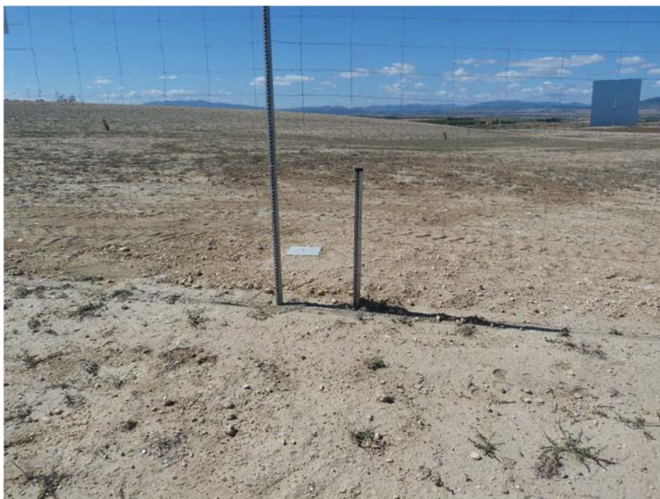
Figura 8.4. Paso de fauna abierto y tapones protectores instalados en los postes del vallado de la planta “Épila 2”. Igualmente se ha hecho en las plantas “Épila 1” y “Épila 3”.
