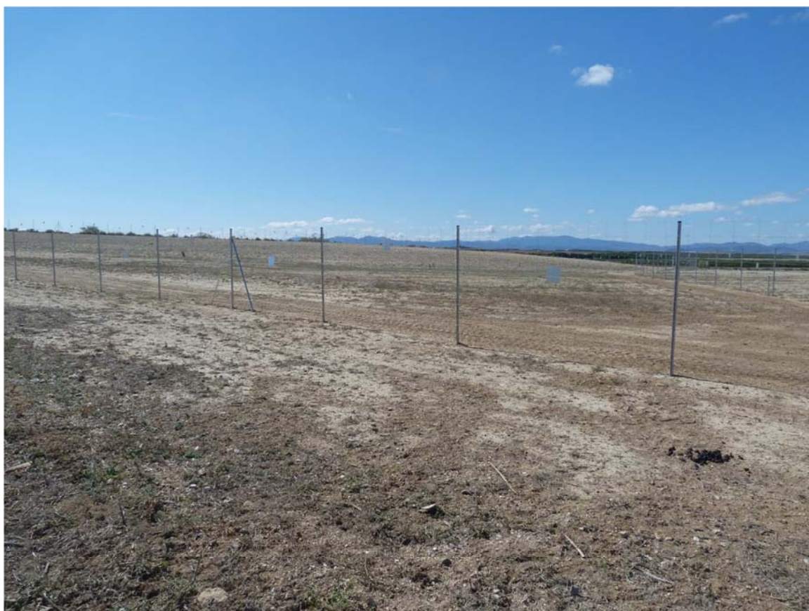
Figura 4.1. Vallado con placas instaladas en “Épila 2”
