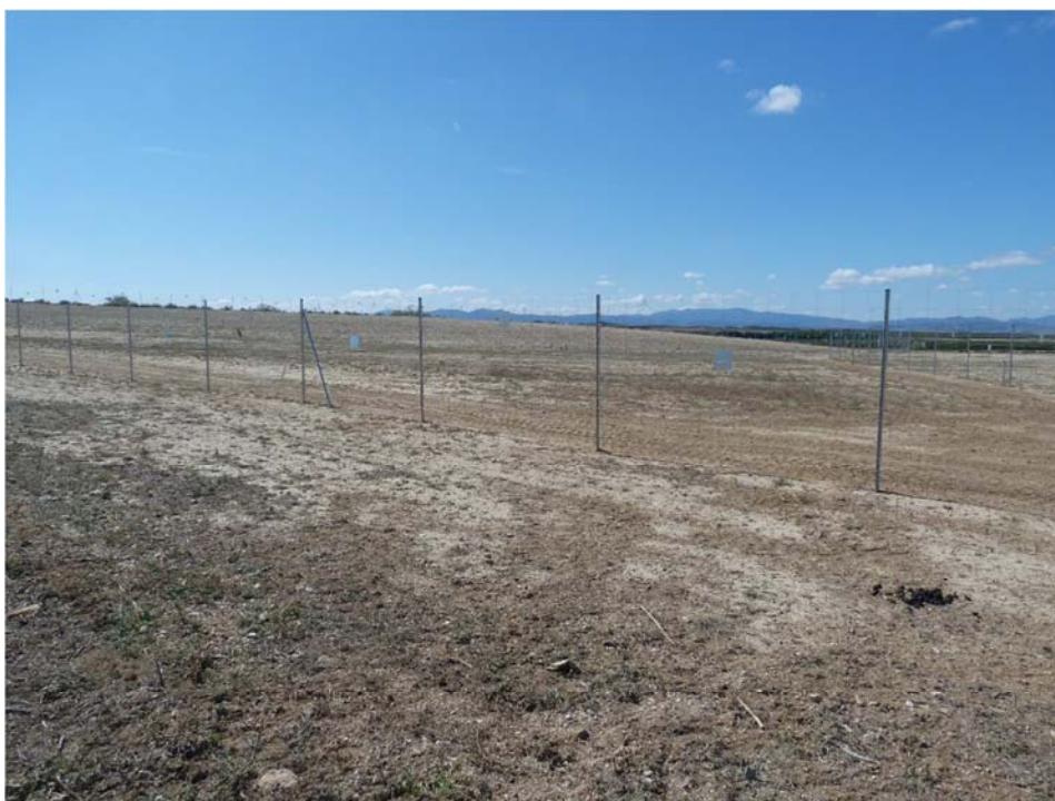
Figura 8.2. Vallado en la planta “Épila 2”, con las placas instaladas y pasos de fauna abiertos
