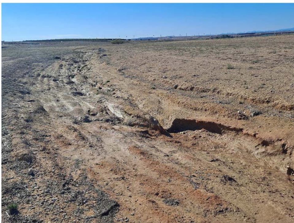
Figura 8.8. Cauce del barranco que atraviesa la planta “Épila 3”, con signos de humedad
