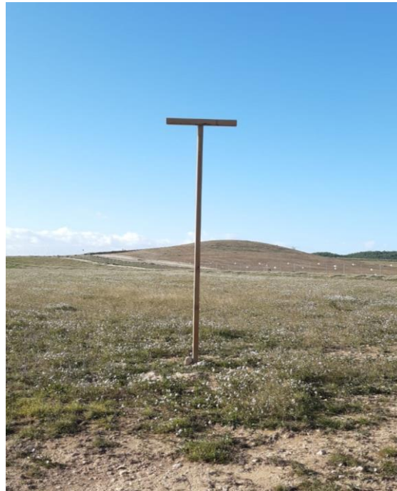
Una de las perchas posadero instaladas dentro del parque fotovoltaico El Zorongo.
