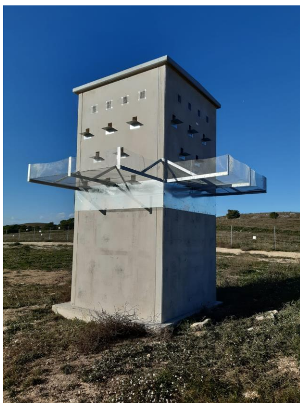
Arriba, aspecto del primillar una vez instalados la chapa antipredación y el sistema anticaída.
