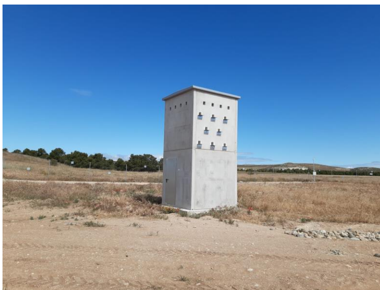
Aspecto inicial de la edificación, antes de realizar las correcciones.
