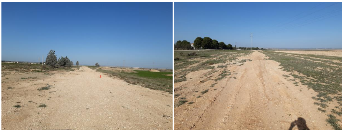
Diferentes tramos de la zanja de evacuación sin cobertura vegetal.
