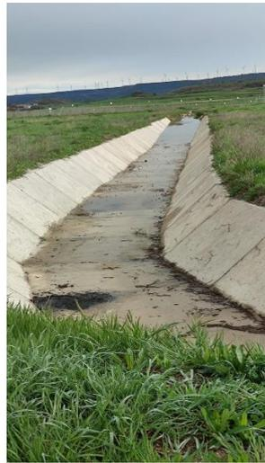
Fig. 1 Acumulación de agua en la cuneta de drenaje
