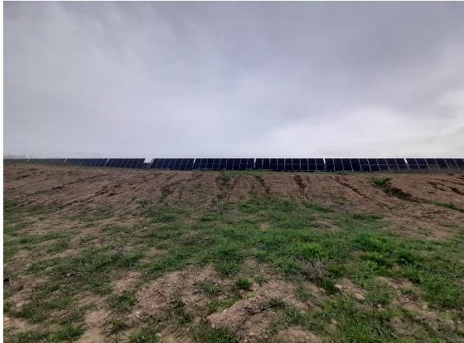
Fig. 2 Regueros en el talud oeste de la planta
