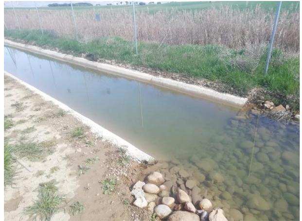
Fig. 1 Acumulación de agua en la cuneta de drenaje
