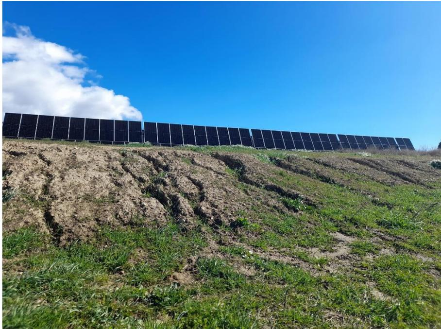
Fig. 1 Erosión hídrica en talud oeste de la planta.
