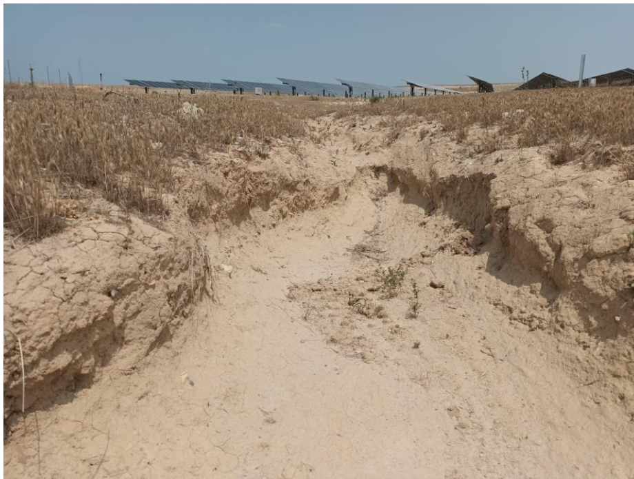
Zona afectada por la erosión.
