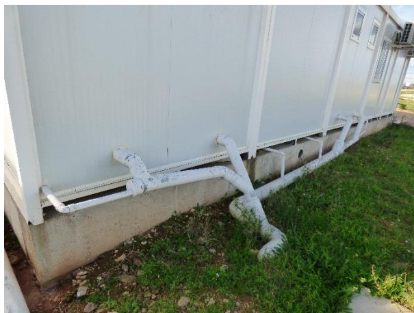
Imagen 2. Tuberías de salida de las aguas residuales de los aseos del edificio de O&M, sin evidencias de desbordamientos
