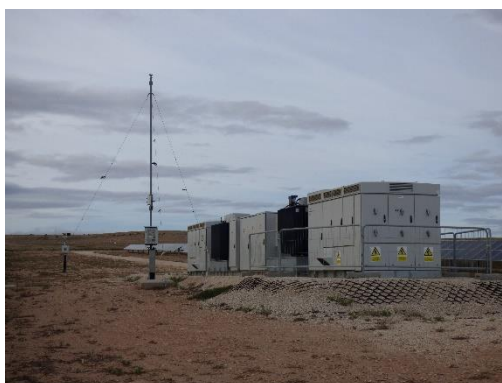
Imagen 4. Periódicamente el promotor revisa las cintas de plástico instaladas en los sensores de las torres anemométricas cuya finalidad es incrementar la visibilidad de los mismos por parte de la avifauna
