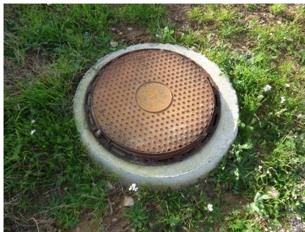
Imagen 1. Tapa de acceso al depósito estanco, sin evidencias de desbordamientos
