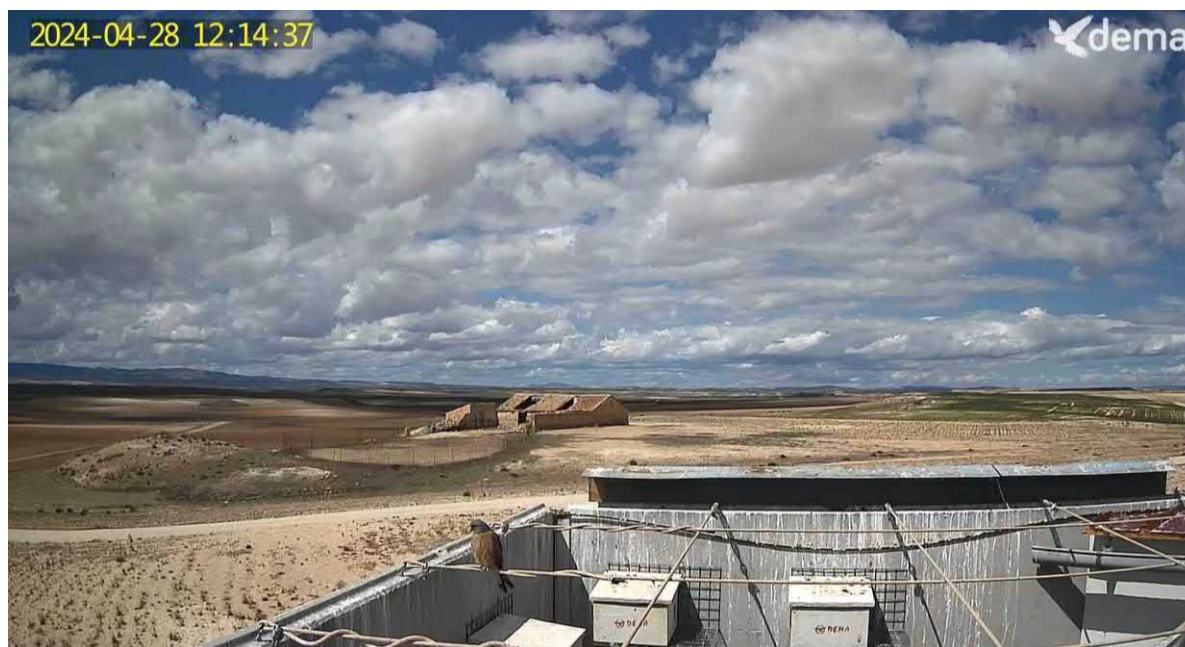
Foto 10- Corral para ganado próximo al edificio-primillar con tejado en proceso de hundimiento
