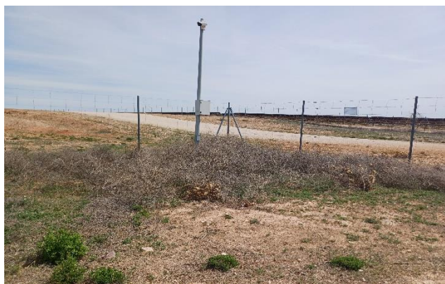
Imagen 5. Acumulación de capitanas en una de las esquinas del vallado perimetral
