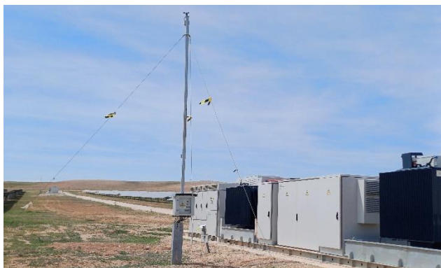
Imagen 6. Periódicamente el promotor revisa las cintas de plástico instaladas en los tensores de las torres anemométricas con el objetivo de incrementar la visibilidad de los mismos por parte de la avifauna
