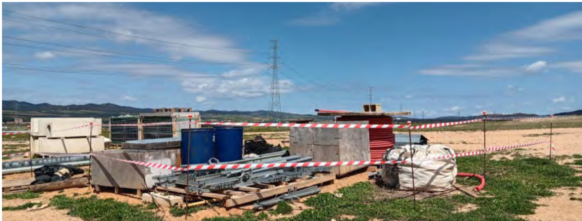
Zona de acopio ordenada y señalizada.
