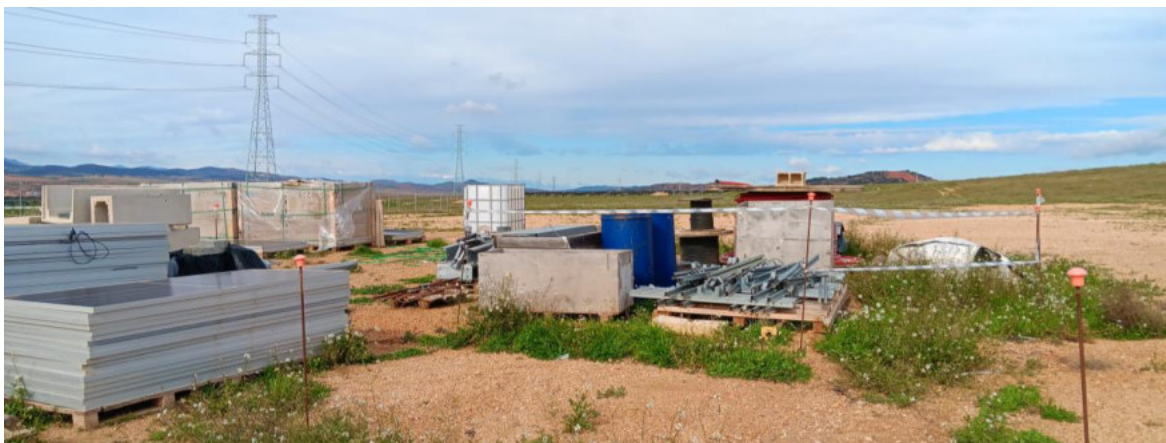
Zona de acopio ordenada y señalizada.
