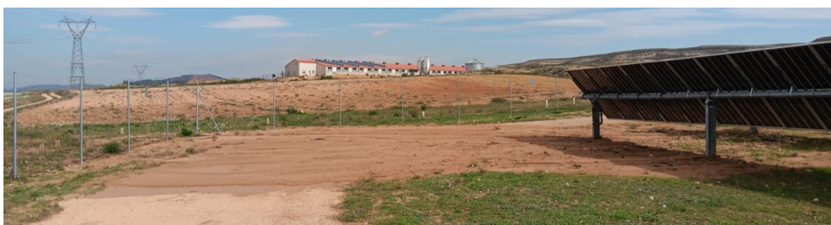
Erosiones en la parcela 3 cerca del talud en el mes de septiembre. Se observa como el arrastre de material ha tapado el camino totalmente.
