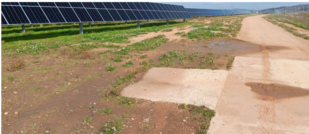
Drenaje rodeado de zona encharcada en la parcela 1 en septiembre.
