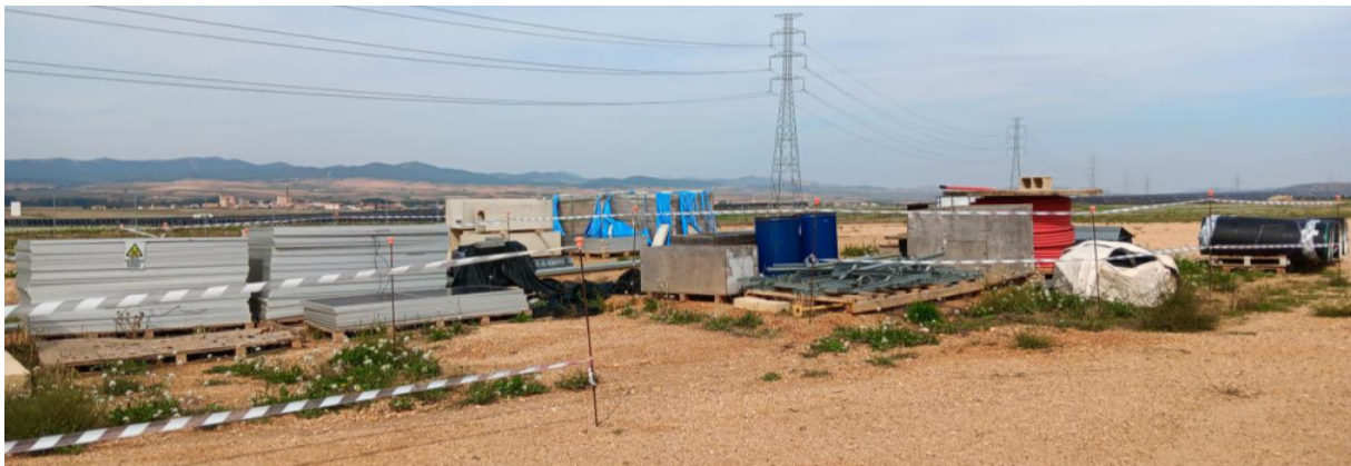
Zona de acopio ordenada y señalizada.
