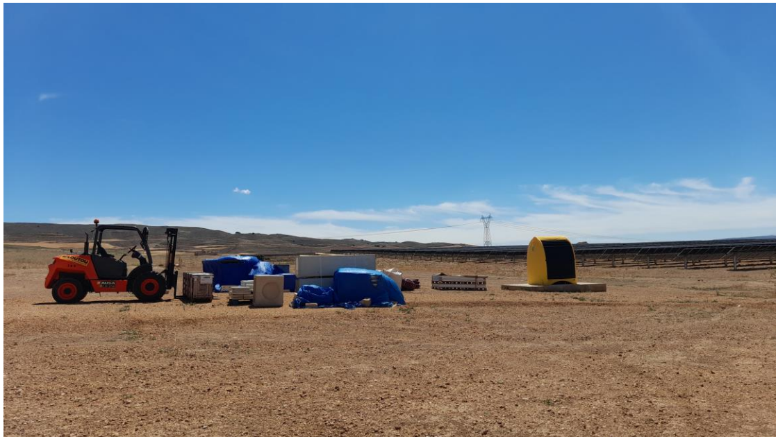
Contenedor para residuos peligrosos y zona de acopios de material, en la parcela 2 del proyecto.
