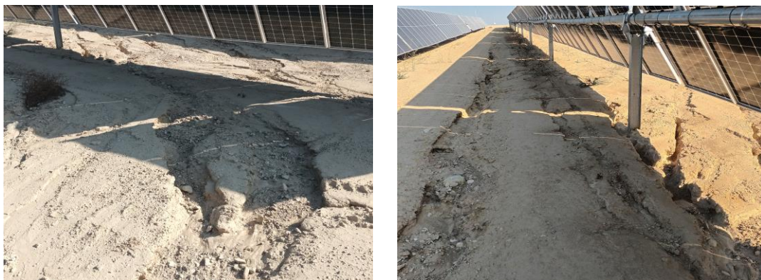
Algunas zonas del proyecto con procesos erosivos incipientes
