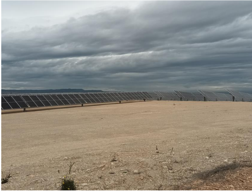
Vista una de las zonas del proyecto en el mes de noviembre
