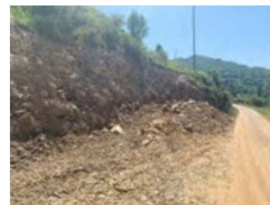
Figura 71: Desmonte de taludes
