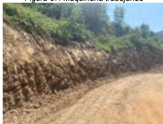
Figura 69: Desmonte de taludes
