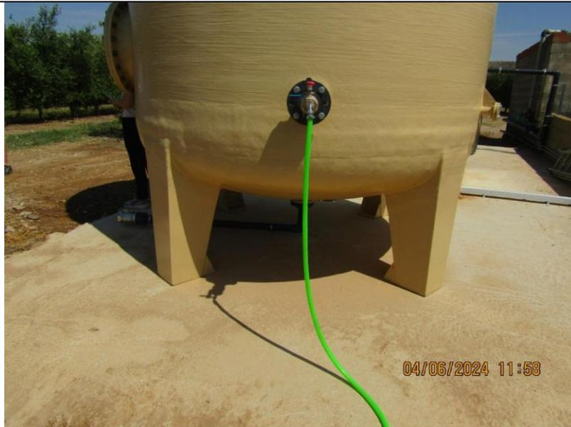
Figura 13.- Depósito de acumulación de agua regenerada y manguera de salida
