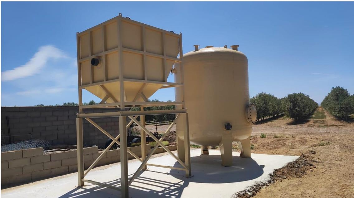
Figura 9.- Elementos ya instalados (depósito de salida y decantador lamelar) en el Periodo 3.
