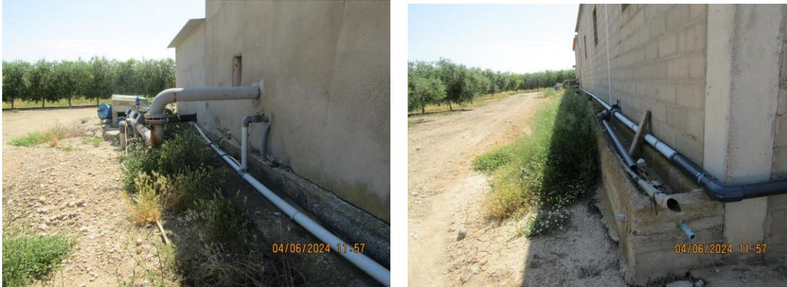
Figura 10: Conexión a red de la Comunidad y parte del recorrido hasta el sistema de regeneración.
