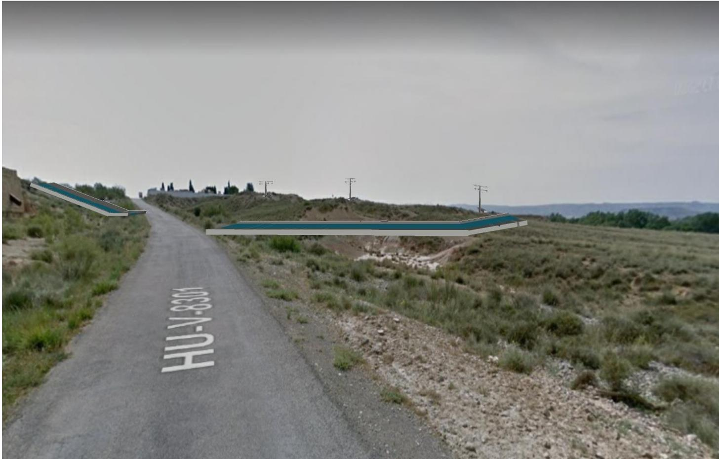
**Imagen 10:** simulación del cruce del canal de derivación con la carretera HU-V-8301 de acceso a Albalatillo y al fondo línea eléctrica de evacuación.
