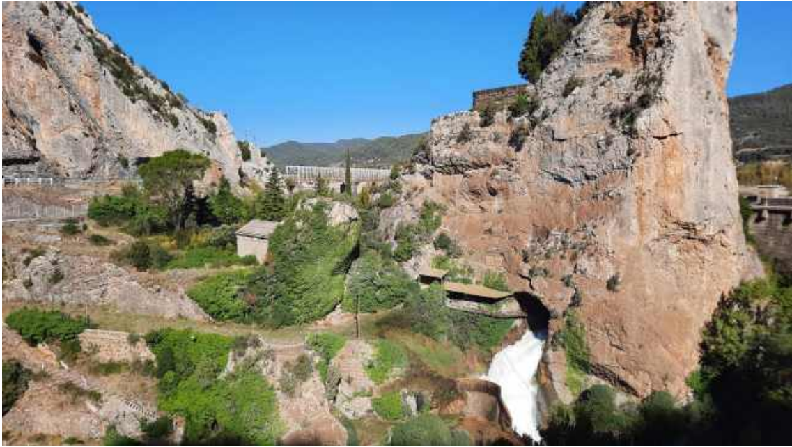
Foto 36. Punto 11. Entorno aguas abajo de la presa con el desgüe de fondo en funcionamiento.
