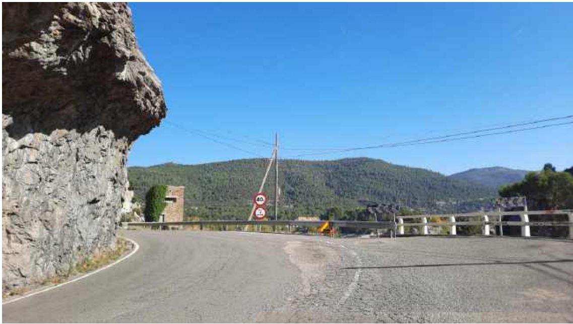
Foto 22. Punto 6. Carretera A - 132, hacia el norte, en el camino de acceso a a la presa. A la izquierda de la carretera talud en roca, vertical y con voladizo superior.
