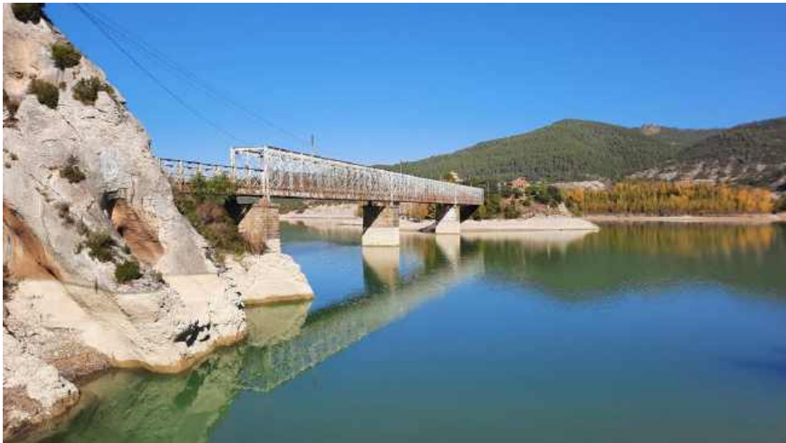
Foto 31. Punto 9. Puente actual desde la presa y en primer plano macizo rocoso sobre el que se construirá el estribo sur del futuro puente.
