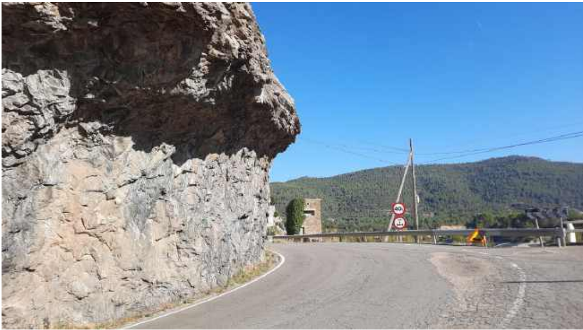
Foto 23. Punto 6. Detalle excavación en roca. Se ha diseñado el vial de acceso sur para no afectar a este talud vertical y voladizo.
