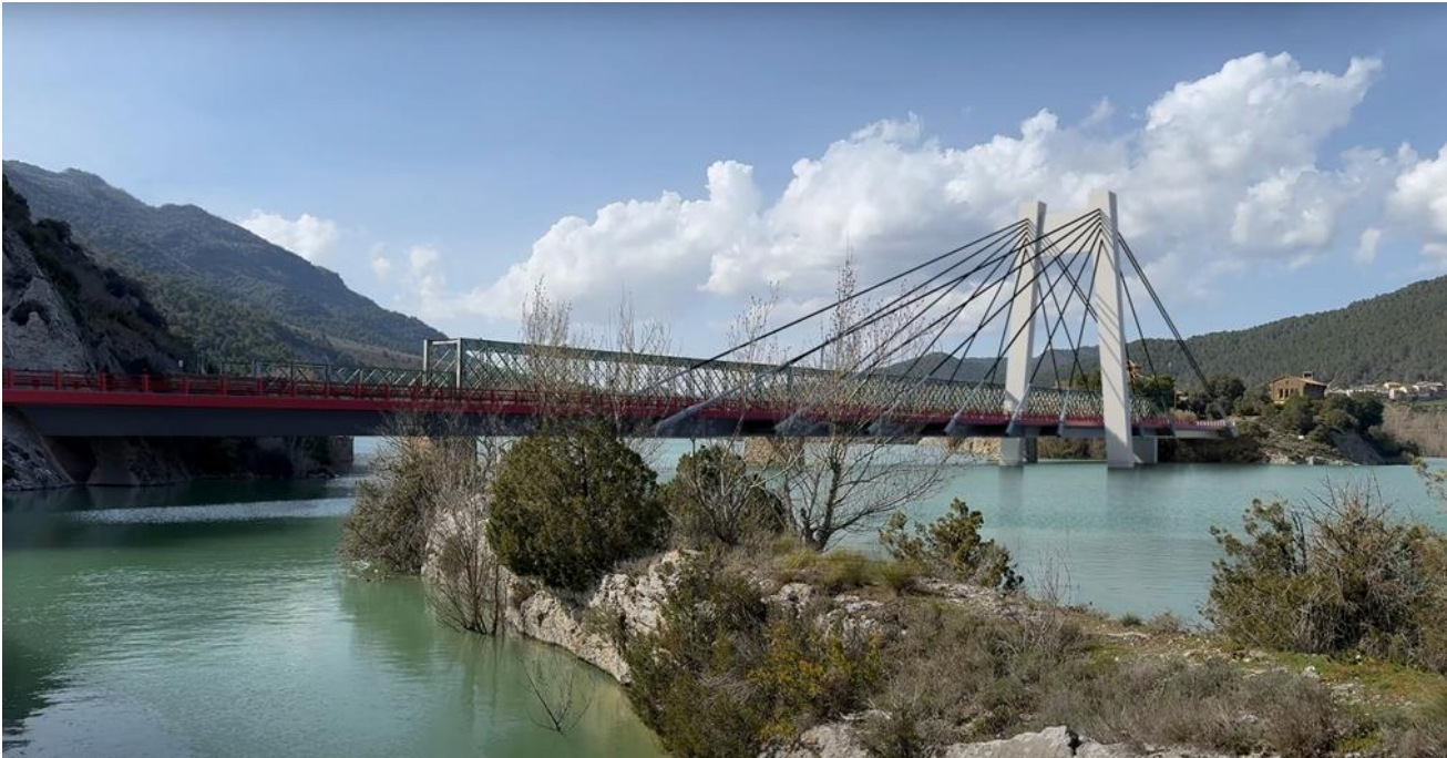
Figura 30. Imagen virtual de una versión inicial (pilono algo más bajo y dos cables menos)
