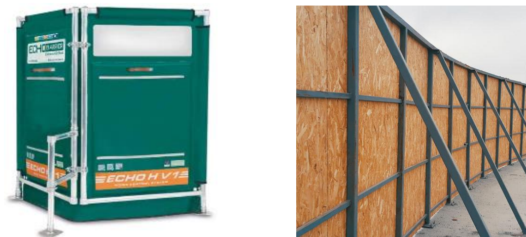
Figura 7. Ejemplos de pantallas temporales durante la fase de obra.
