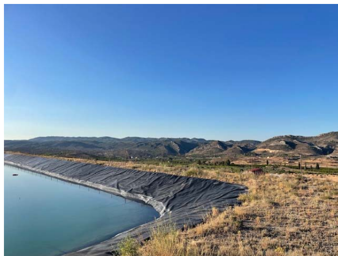
Foto 6: Balsa de riego, al fondo se ve la zona de cultivo que se suministra desde la misma, foto realizada hacia el Sur.
