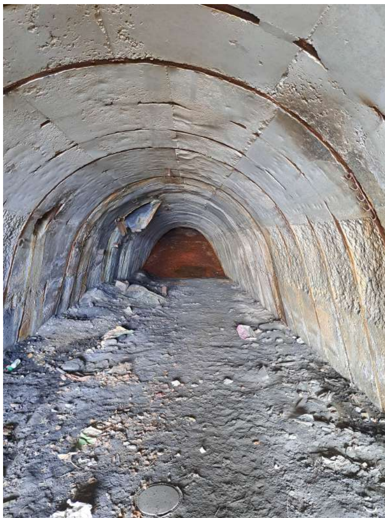
Imagen 32. Bocamina antigua con el nivel de agua próximo a la entrada.
