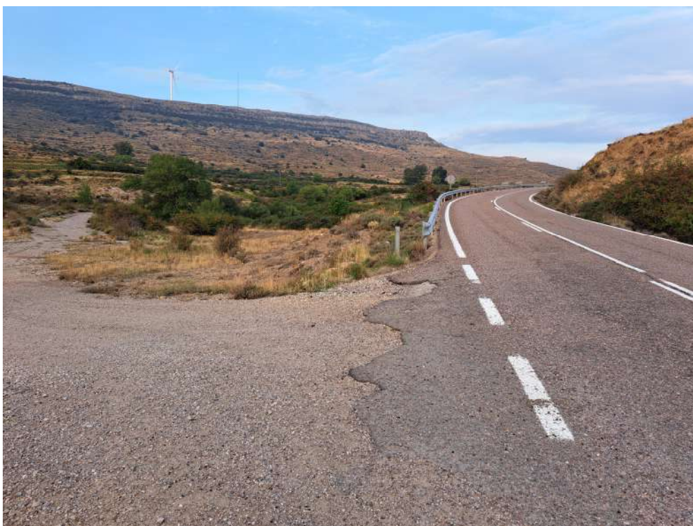
Imagen 31. Zona de acceso a la explotación desde el desvío de la carretera A-2402 hacia Palomar y área donde se prolongará la pantalla visual mediante la plantación de chopos, coincidente en esta zona con el área donde se implantará el acopio de arcillas.
