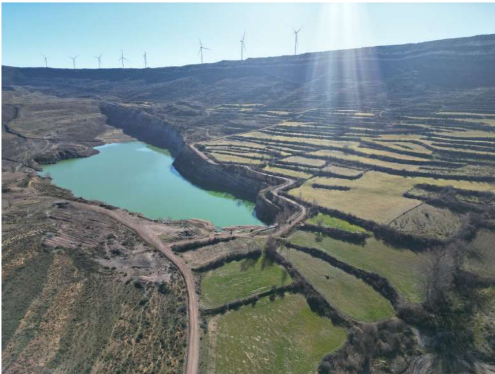
Imagen 2. Balsa de agua del lado oeste
