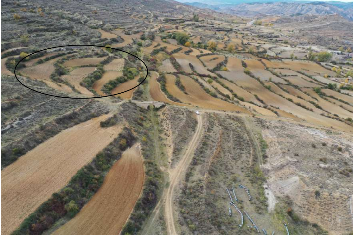
Imagen 23. Acopio de tierra vegetal sobre los campos abancalados existentes en zona enmarcada en la imagen.
