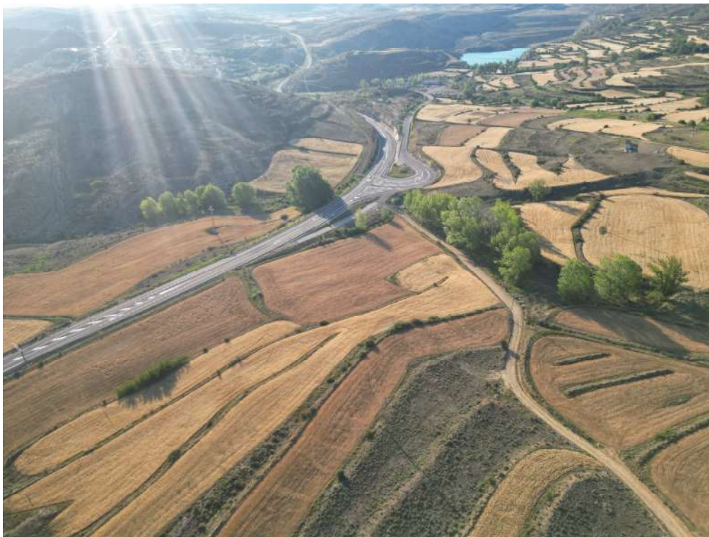
Imagen 6. Zona de incorporación y salida desde la carretera A-2402 y el camino de acceso a la explotación.
