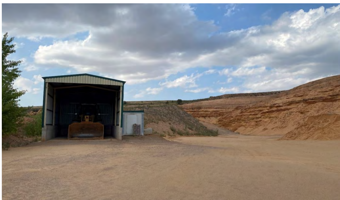
Foto 7. Cobertizo para maquinaria
