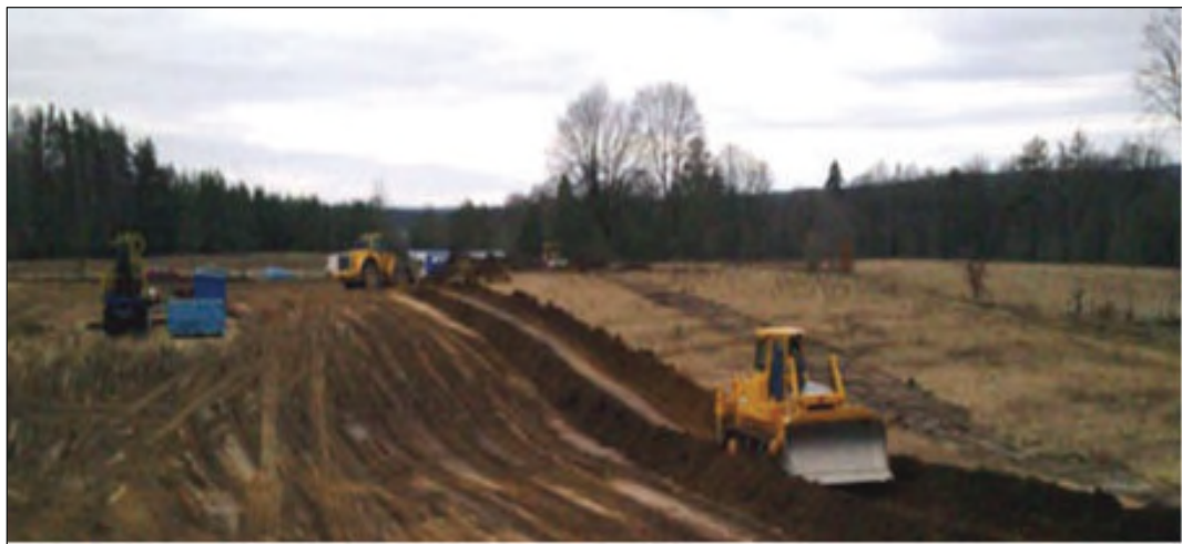
Figura 19. Ejemplo de nivelación de terreno
