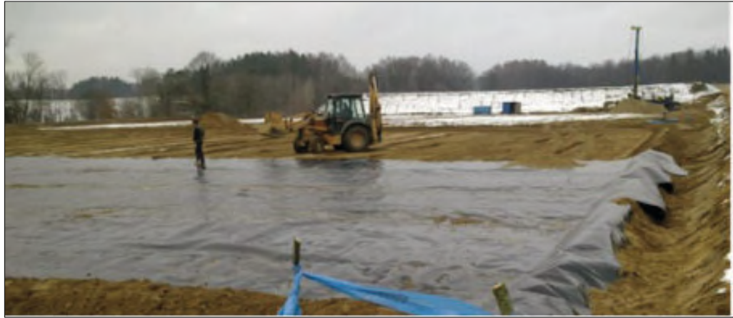
Figura 20. Ejemplo de impermeabilización del emplazamiento
