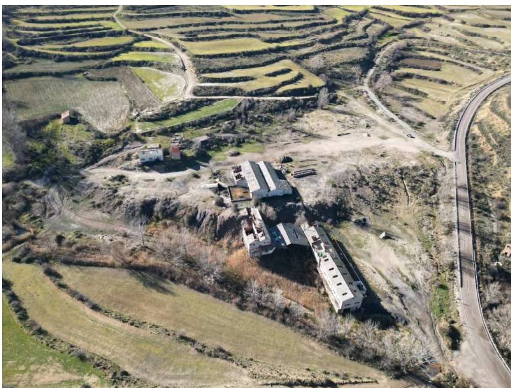
Foto 4. Antiguas edificaciones de Minas Palomar que van a ser derruidas y donde se pretende instalar el acopio de arcillas, que ocupará además los campos de alrededor y en una zona próxima a la carretera de acceso a Palomar de Arroyos.
