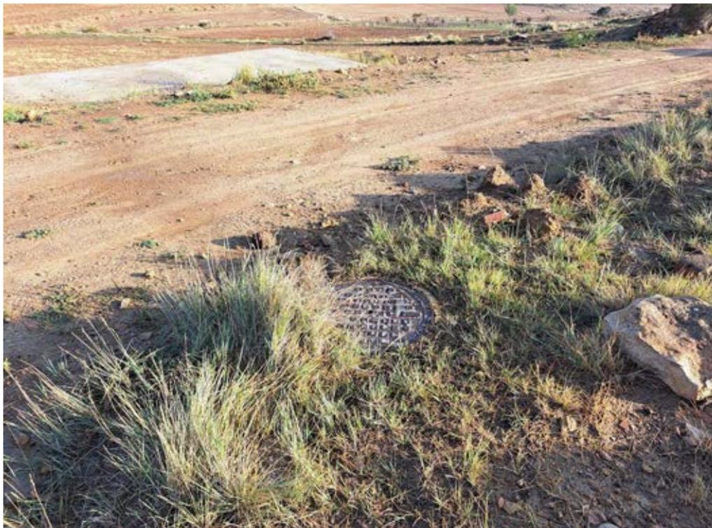
*Foto 20. Registro de la tubería de aguas cuyo trazado va sobre el camino de acceso a la explotación.*
