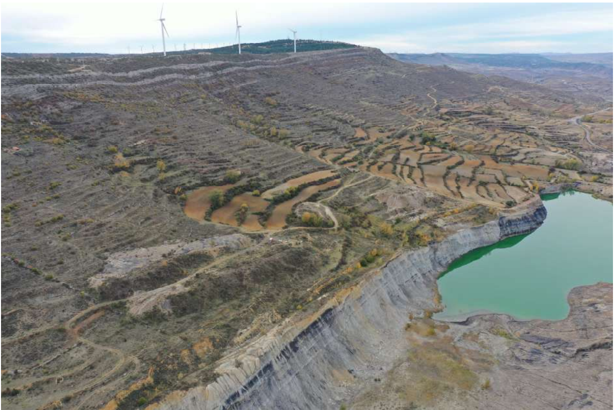
Imagen 4. Vista general del área donde se desarrollarán las dos zonas de explotación, coincidente con la zona de menor pendiente en ladera donde se localizan los campos de cultivo abancalados en uso, así como algunas escombreras antiguas.
