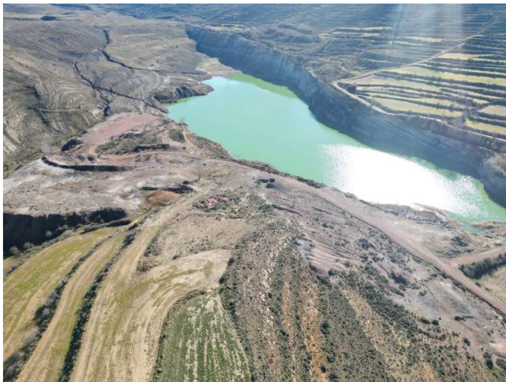
Imagen 17. Balsa de agua rellenoando el hueco minero y escombreras antiguas.
