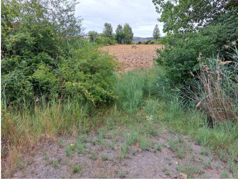
Imagen 2. Detalle del paso existente sobre el Río Palomar. Este paso deberá de ser acondicionado y agrandado para permitir el paso de vehículos pesados.
