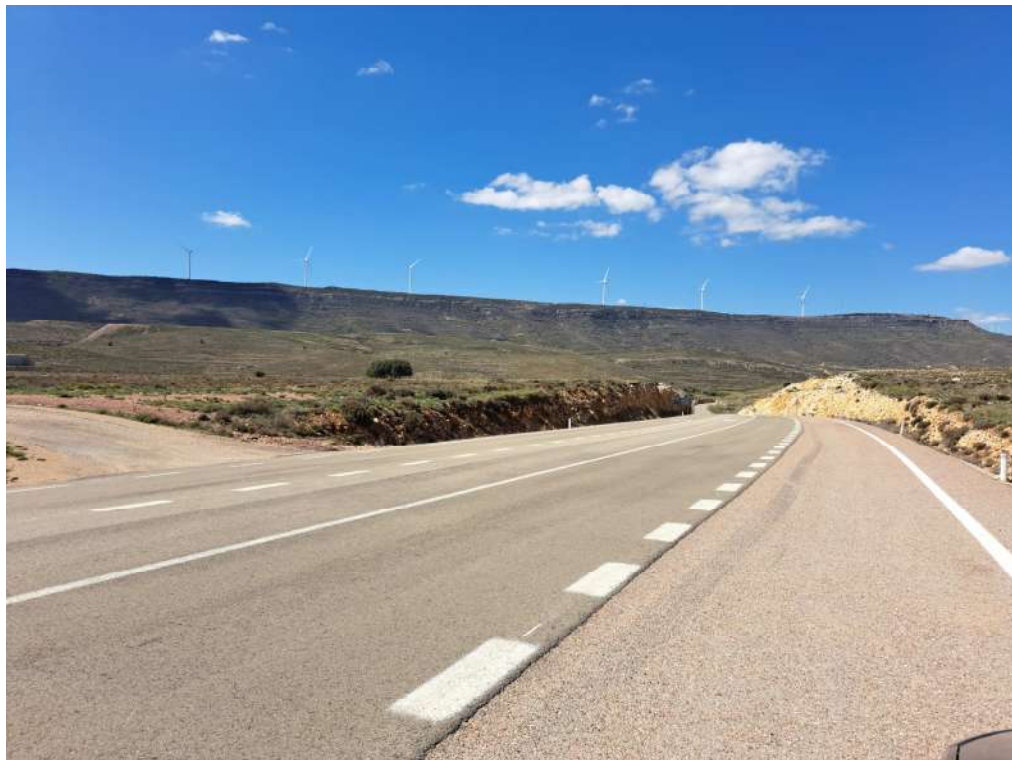
Imagen 25. Vista desde la carretera A-2402 hacia las zonas de explotación, no visibles por el relieve alomado y las trincheras a lo largo de la carretera.
