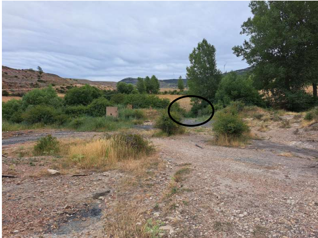
Imagen 1. Vista general de la zona de paso entre las antiguas instalaciones de Minas Palomar y los campos de cultivo próximos. Enmarcada, la zona de paso y cruce sobre el Río Palomar.
