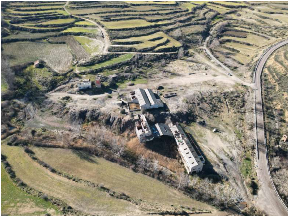
Foto 4. Antiguas edificaciones de Minas Palomar que van a ser derruidas y donde se pretende instalar el acopio de arcillas, que ocupará además los campos de alrededor y en una zona próxima a la carretera de acceso a Palomar de Arroyos.
