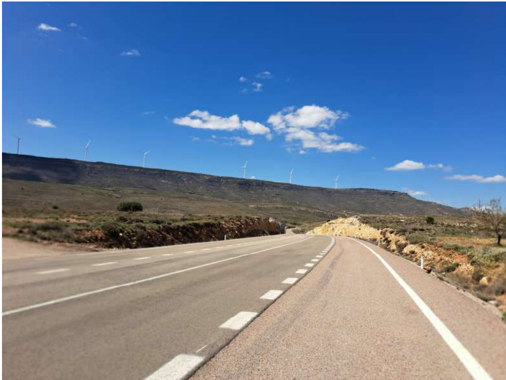
Foto 10. Relieves a lomados y zonas en trinchera de la carretera A-2402 que limitan la visibilidad de la explotación de Minas Palomar desde la principal vía de comunicación.
