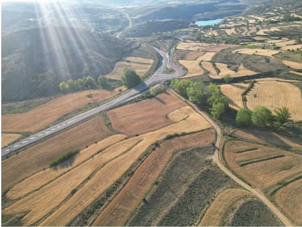
Foto 3. Vista de la carretera A-2402 en el cruce hacia Palomar de Arroyos por donde se accederá a la explotación de Mina Victoria.
