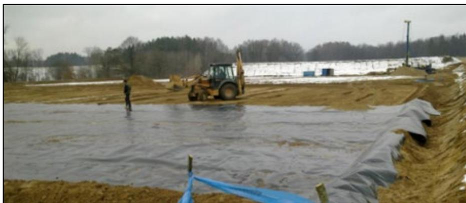
*Figura 6. Ejemplo de impermeabilización del emplazamiento*
