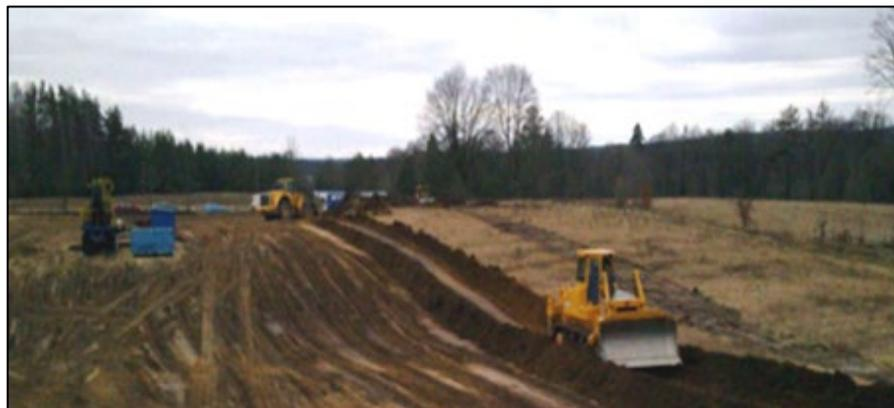
*Figura 5. Ejemplo de nivelación de terreno*
