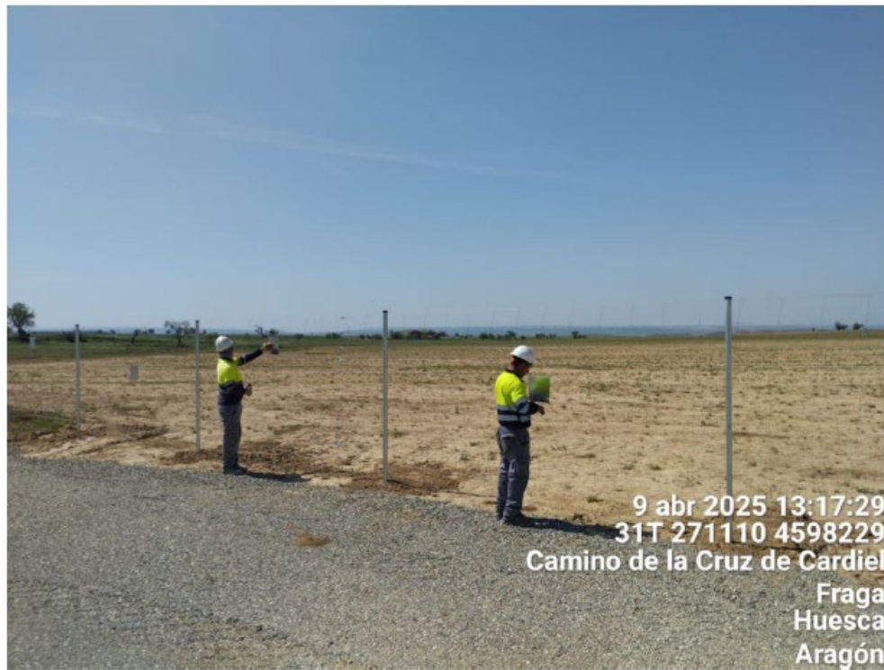
Ilustración 2. Colocación de placas anticolisión avifauna en el vallado perimetral
