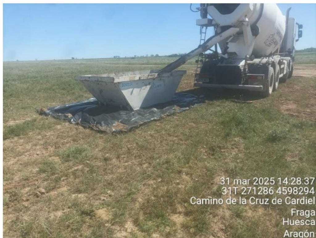
Ilustración 2. Lavado de hormigonera en zona habilitada
