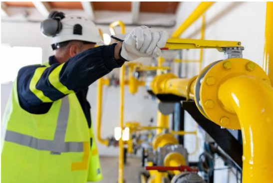
Tubería en instalación gasista. Foto cortesía Redexis
