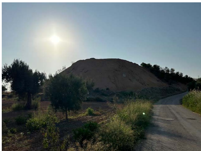
Foto 17: Vista de la zona Oeste y el lateral Sur con algún pino.
