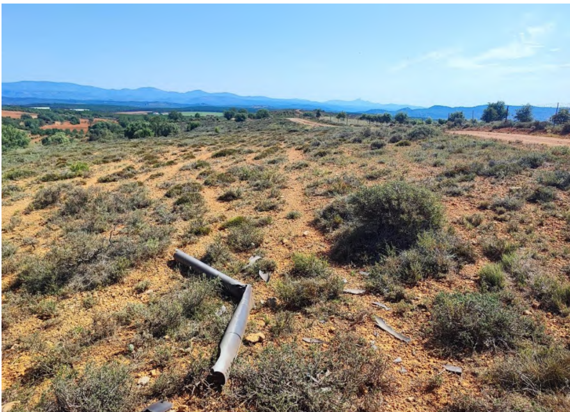
Figura 5. Arriba: Tubo de registro de tubería junto al margen del camino. Abajo: Restos de tubería abandonados en las proximidades del camino.
