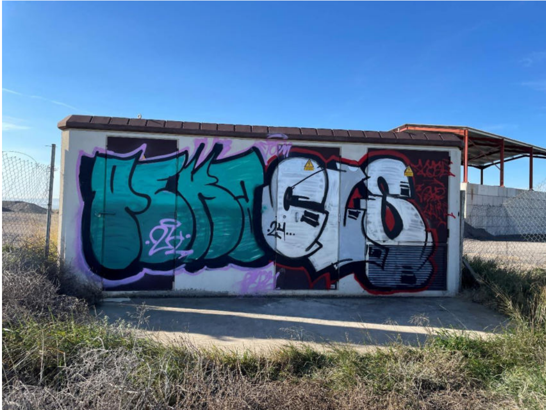
Centro de transformación para el suministro de PAPSA. CT ENDESA nº: 62038
