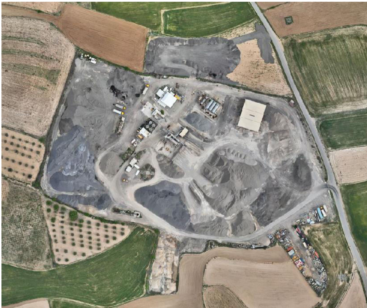
Vista aérea de planta de asfaltos PAPSA
