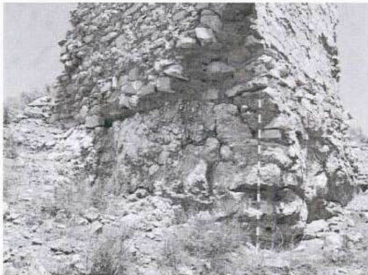
Arranque del torreón sobre los niveles geológicos de yesos.
