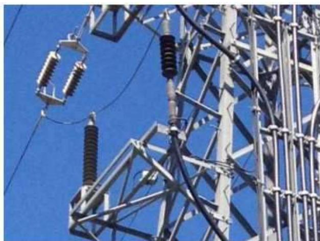
*Unión conductor aéreo-pararrayos-terminal*
