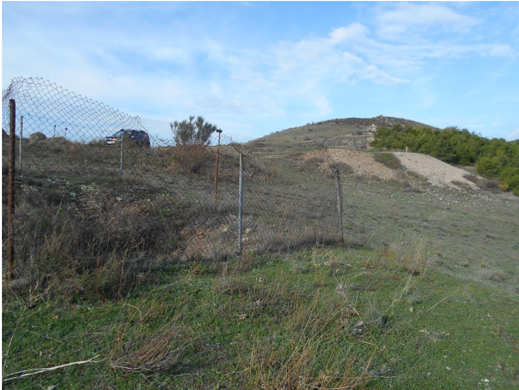
Foto 2. Panorámica de la escombrera y dos pozos vallados de la mina Leonor.
