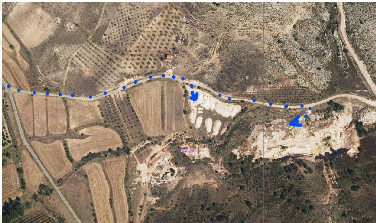
Figura 73. Trazado del camino de acceso ya existente
